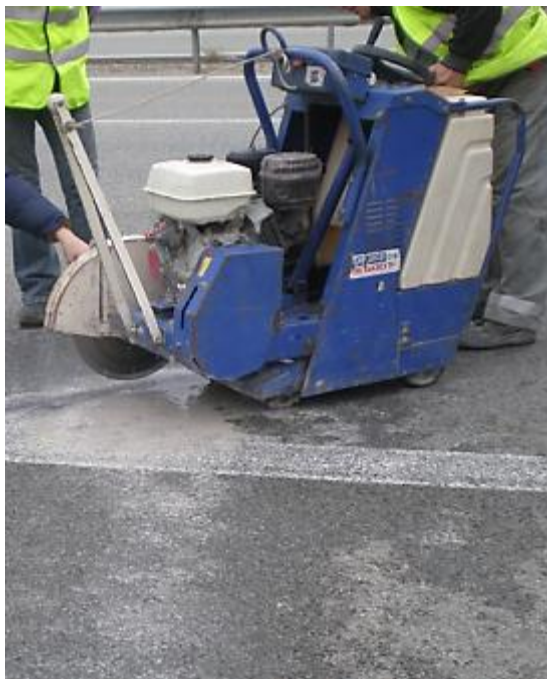
Εικόνα 4.7 Διάνοιξη αρμών για τα καλώδια των αισθητήρων οπτικών ινών
