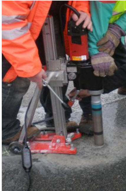
Εικόνα 4.5 Πυρηνοληψία με ειδικό μηχάνημα (καροτιέρα)
