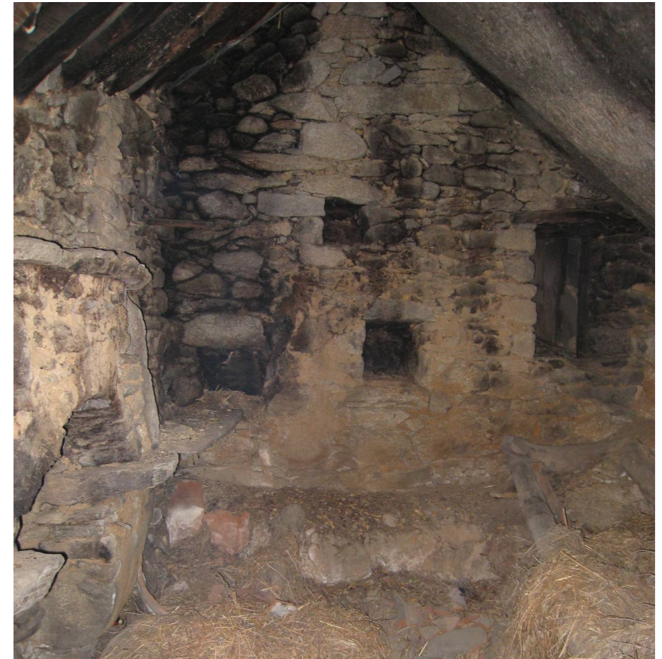
Εσωτερικό χυτού. Στα δεξιά διακρίνεται η είσοδος για το χωστοκέλι και ο βράχος στον οποίο εφάπτεται το κτίσμα.
