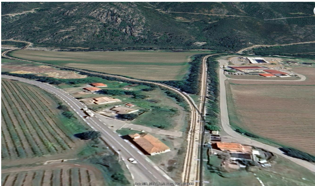
Εικόνα 2.6 - 3D αναπαράσταση Google Earth: Η γραμμή στην απόληξη της περιοχής του σταθμού του Ponte Leccia με κατάλληλο σύστημα αλλαγών μερίζεται προς Calvi/Bastia
