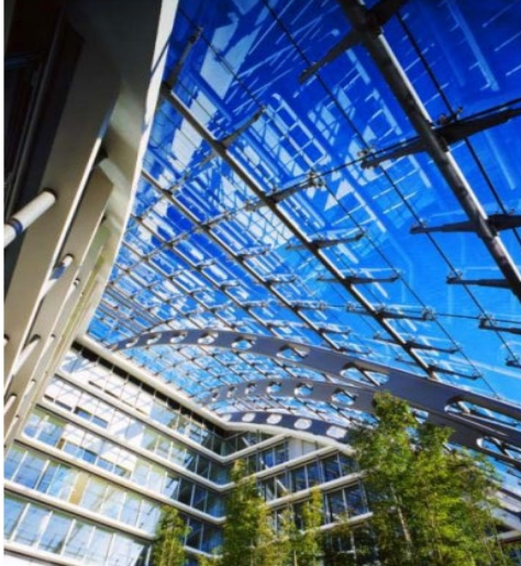
Εικόνα 1-7: Μεταλλικοί φορείς περίπλοκης γεωμετρίας, προστατευόμενοι από διογκούμενες βαφές ( bauforumstahl.de ) [17].
