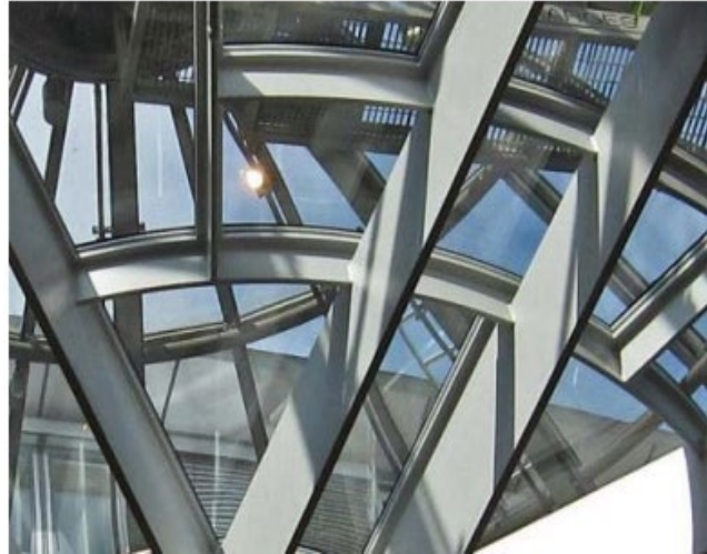
Εικόνα 1-7: Μεταλλικοί φορείς περίπλοκης γεωμετρίας, προστατευόμενοι από διογκούμενες βαφές ( bauforumstahl.de ) [17].
