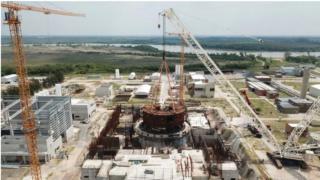
Εικόνα 3.3: Ο αντιδραστήρας CAREM της Αργεντινής, ένας από τους πρώτους μικρούς αρθρωτούς αντιδραστήρες υπό κατασκευή. Είναι ένας iPWR 100 MWt (27 MWe μικτού) παλαιότερου σχεδιασμού (ανακοινώθηκε για πρώτη φορά το 1984). Διαθέτει 12 γεννήτριες ατμού μέσα στο δοχείο πίεσης (Πηγή: CNEA).
