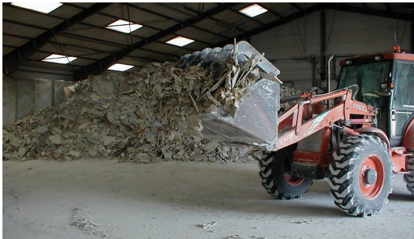
Εικόνα 9.3 Αποθήκη συγκέντρωσης γυψοσανίδων προς ανακύκλωση
