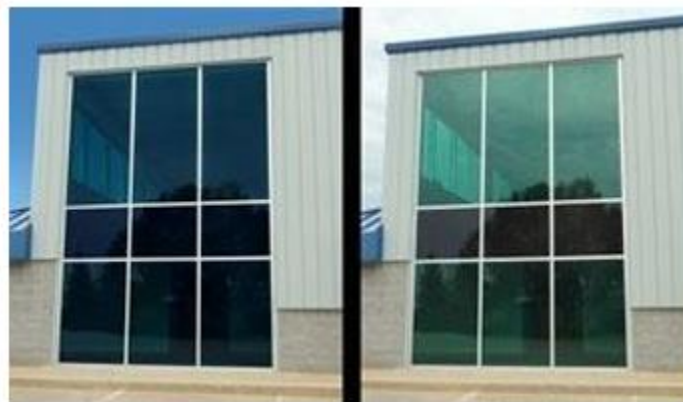
Εικόνα 14. Θερμοχρωμικοί υαλοπίνακες Suntuitive, στα αριστερά σε κατάσταση ελάχιστης διαπερατότητας και στα δεξιά σε κατάσταση μέγιστης διαπερατότητας [38]
