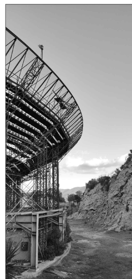
ΜΕΤΑΛΛΙΚΗ ΚΑΤΑΣΚΕΥΗ ΘΕΑΤΡΟΥ
