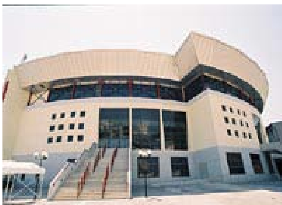
Πρόσοψη Ολυμπιακού Κέντρου
