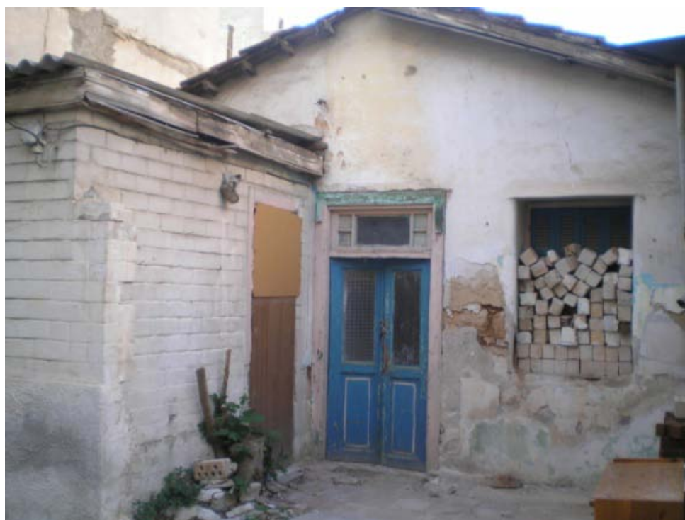
Κτίσμα από την δεκαετία 1920 - 1930
