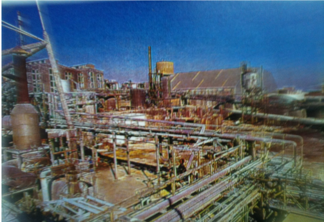
Εργοστάσιο των Λιπασμάτων στην βιομηχανική περιοχή της Δραπετσώνας, (Νικ. Καλαμίτση : << Η βιομηχανία του Πειραιώς από το 1840 ως το 1960>>, Πειραιεύς 1960,σελ 45)
