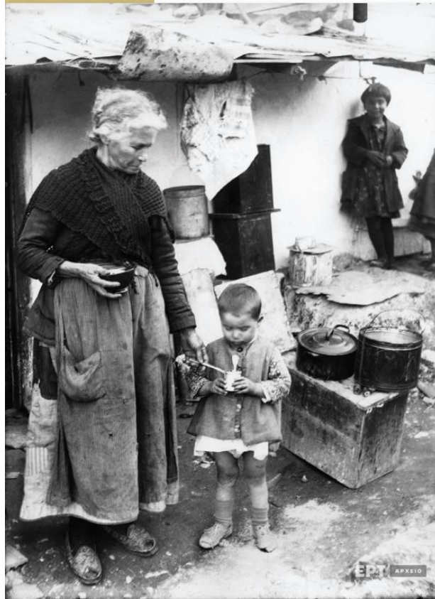
Εικόνα 8: Εγκατάσταση προσφύγων. Διακρίνεται η υπαίθρια αυτοσχέδια κουζίνα έξω από το κτίριο
