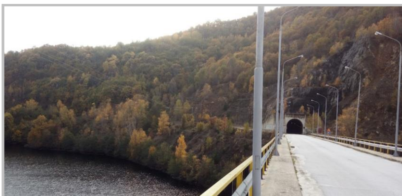
Εικόνα 91: Είσοδος σήραγγας πλησίον ΥΗΕ Πλατανόβρυσης (ΦΡΑΓΜΑ ΠΛΑΤΑΝΟΒΡΥΣΗΣ - Χάρτες Google)
