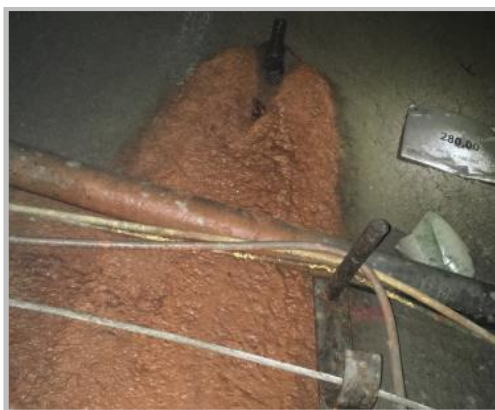
Εικόνα 28: Εκτοξευόμενο σκυρόδεμα υπό επίδραση μικροοργανισμών (Τροποποιημένη εικόνα από αναφορά “Durability of shotcrete for underground support– Review and update”, Isabel Galan , Andre Baldermann, Wolfgang Kusterle, Martin Dietzel, Florian Mittermayr, Construction and Building Materials, Volume 202, 2019)
