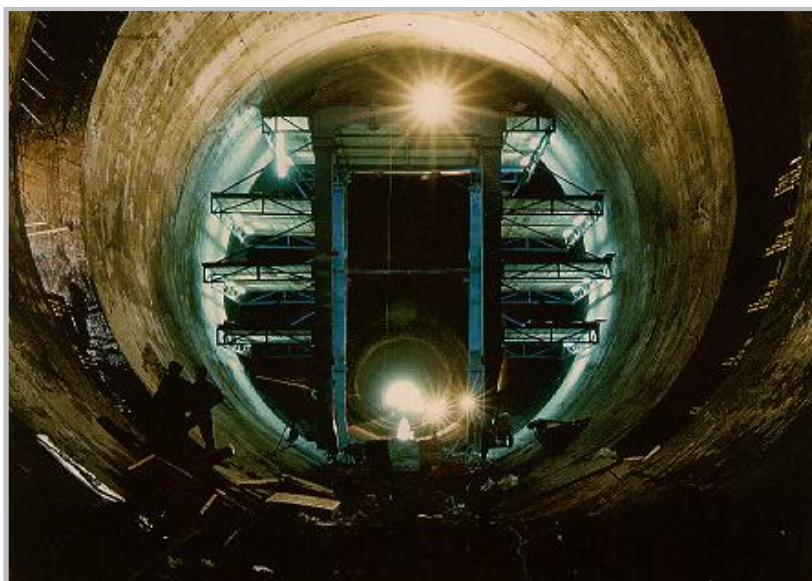
Εικόνα 60: Σήραγγα εκτροπής-τσιμεντενέσεων, εκσκαφή εκχειλιστή-ΥΗΕ Ιλαρίωνα (Σήραγγες – Michaniki)
