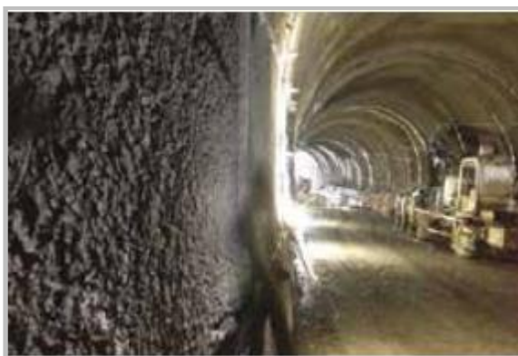
Εικόνα 9: Strathfield – Αυστραλία, Εφαρμοσμένο ενισχυμένο με συνθετικές ίνες εκτοξευόμενο σκυρόδεμα σε σήραγγα προσπέλασης (“Permanent Sprayed Concrete Linings”, ITA Working Group 12 and ITAtech. - Longrine-Avignon, France: International Tunneling and Underground Space Association, 2020)
