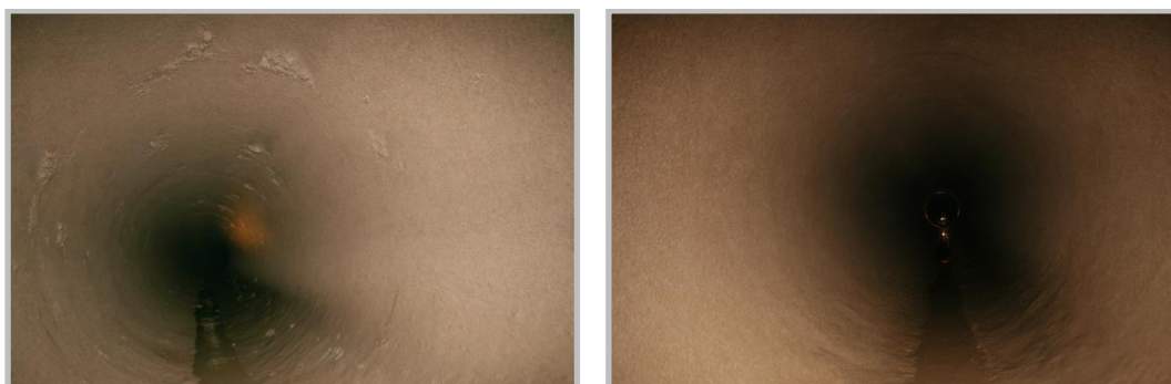
Εικόνα 141: Εσωτερικό σήραγγας προσαγωγής ΥΗΕ Λάδωνα πριν και μετά τις εργασίες καθαρισμού στο εσωτερικό της, οι οποίες πραγματοποιήθηκαν το έτος 2010 (Αρχείο εγκαταστάσεων ΥΗΣ Λάδωνα ΔΕΗ ΑΕ)
