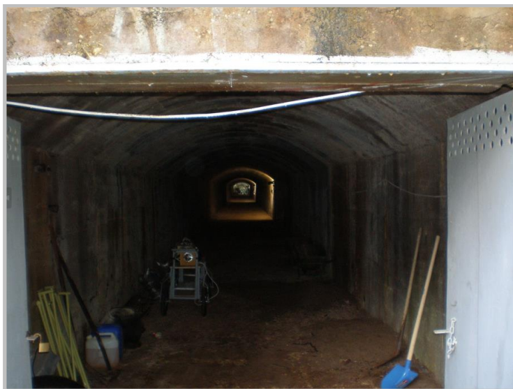
Εικόνα 140: Επισκέψιμη στοά προσπέλασης σήραγγας προσαγωγής ΥΗΕ Λάδωνα (Αρχείο εγκαταστάσεων ΥΗΣ Λάδωνα ΔΕΗ ΑΕ)
