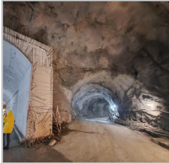
Εικόνα 105: Φωτογραφία αριστερής σήραγγας προς σταθμό παραγωγής και δεξιάς σήραγγας προς την αντίστοιχη προσαγωγή (Φωτογραφικό υλικό ΔΕΗ ΑΕ)
