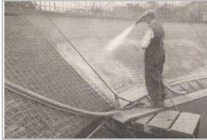
Εικόνα 4: Ακροφύσιο προσαρμοσμένο στο κεφάλι του τεχνίτη κατά την κατασκευή δεξαμενής νερού το 1919, Yoggy, 2000 («Επισκευές και ενισχύσεις κατασκευών», Στέφανος Η. Δρίτσος)
