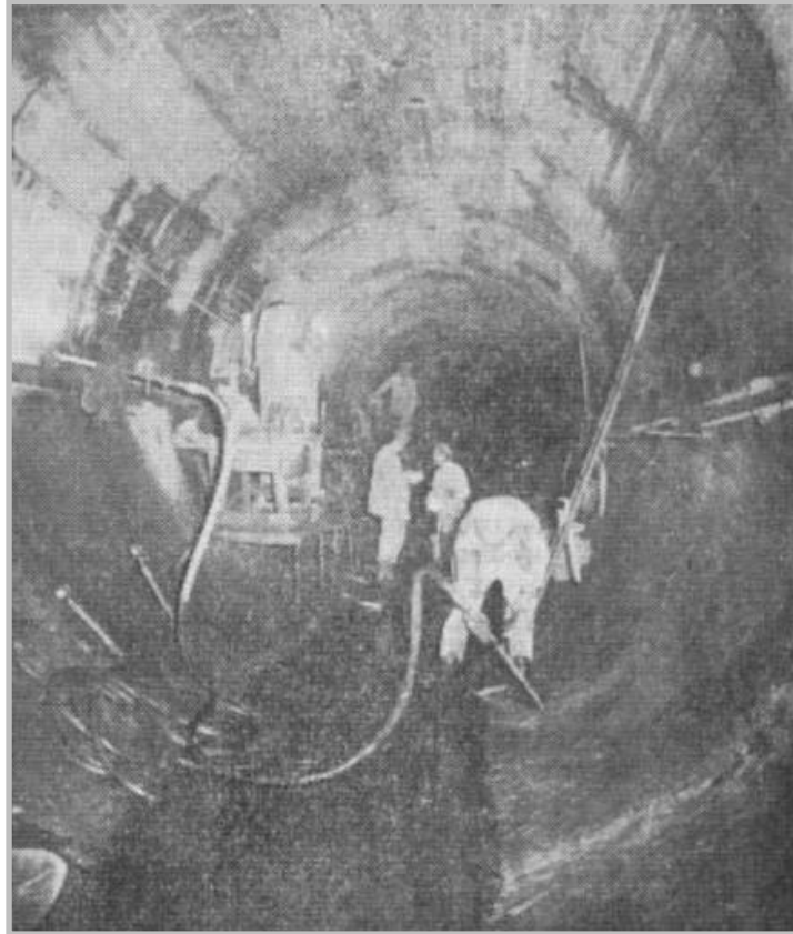
Εικόνα 139: Εφαρμογή επένδυσης τσιμεντενέσεων επαφής στο διάστημα 1951-1955 κατά την κατασκευή του ΥΗΕ Λάδωνα (Αρχείο εγκαταστάσεων ΥΗΣ Λάδωνα ΔΕΗ ΑΕ)
