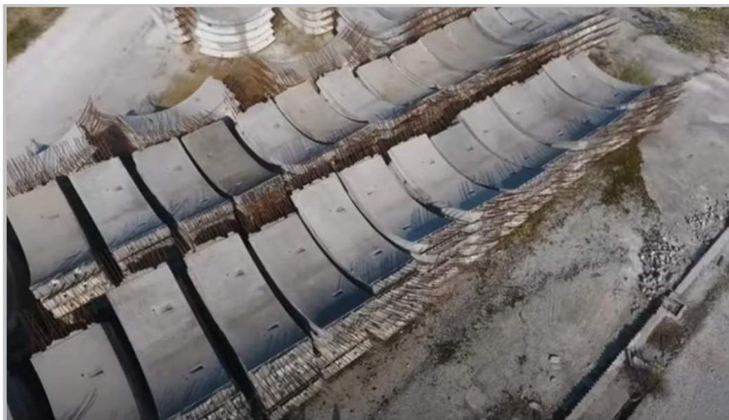
Εικόνα 38: Προκατασκευασμένα στοιχεία μόνιμης επένδυσης στην έξοδο της σήραγγας εκτροπής Αχελώου στη θέση Δρακότρυπα Θεσσαλίας (2018 09 17 Η Σήραγγα εκτροπής Αχελώου - YouTube)
