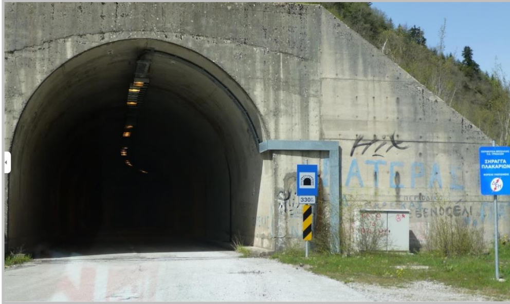
Εικόνα 46: Είσοδος οδικής σήραγγας Πλακαριών (Μεσοχώρα - Χάρτες Google)
