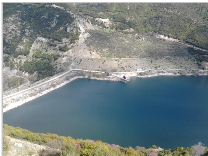
Εικόνα 67: Τεχνητή Λίμνη Πολύφουτου (Φωτογραφίες ΥΗΕ Πολύφουτου, https://lengen.gr/el/2017/06/12/ελληνικά-επίσκεψη-υδροηλεκτρικός-στ/ )
