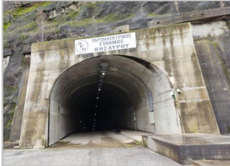
Εικόνα 84: Σήραγγα προσπέλασης προς τον ΥΗΣ Θησαυρού (Φράγμα ΥΗΕ Θησαυρού - https://www.google.com/maps )
