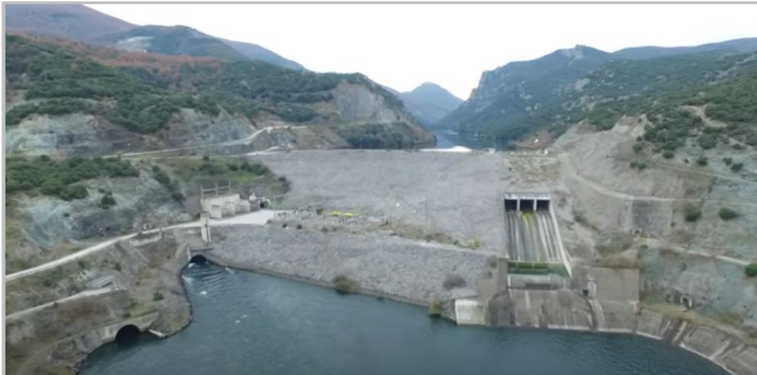
Εικόνα 63: Φράγμα Ασωμάτων (Φράγμα Ασωμάτων-Βέροια - YouTube)
