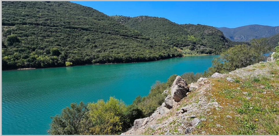
Εικόνα 129: Τεχνητή Λίμνη Λάδωνα (Φωτογραφίες ΥΗΕ Λάδωνα - Φράγμα ΥΗΣ Λάδωνα - Χάρτες Google )
