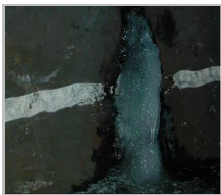
Εικόνα 24: Εκτοξευόμενο σκυροδέμα με βλάβη από έκθεση σε κύκλους ψύξης - απόψυξης (Τροποποιημένη εικόνα από αναφορά “Durability of shotcrete for underground support– Review and update”, Isabel Galan , Andre Baldermann, Wolfgang Kusterle, Martin Dietzel, Florian Mittermayr, Construction and Building Materials, Volume 202, 2019)
