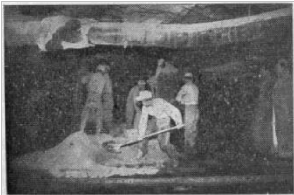
Εικόνα 123: Παρασκευή ενέματος στην στοά 2 ΥΗΕ Άγρα (Αρχείο εγκαταστάσεων ΥΗΣ Λάδωνα ΔΕΗ ΑΕ)
