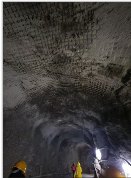
Εικόνα 104: Φωτογραφίες τμήματος σήραγγας που παραμένει με επένδυση εκτοξευόμενου σκυροδέματος μέχρι τη σημερινή εποχή, στο ΥΓΕ Μετσοβίτικου (Φωτογραφικό υλικό ΔΕΗ ΑΕ)
