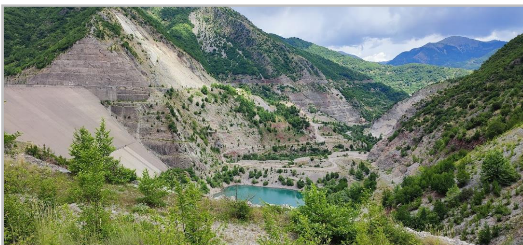
Εικόνα 45: ΥΗΕ Μεσοχώρας Θεσσαλίας (Μεσοχώρα - Χάρτες Google)
