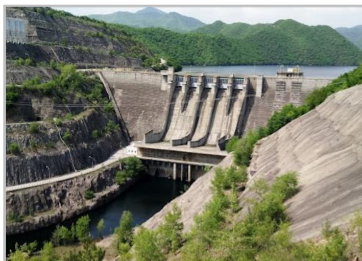
Εικόνα 87: Φράγμα ΥΗΕ Πλατανόβρυσης (ΦΡΑΓΜΑ ΠΛΑΤΑΝΟΒΡΥΣΗΣ - Χάρτες Google)
