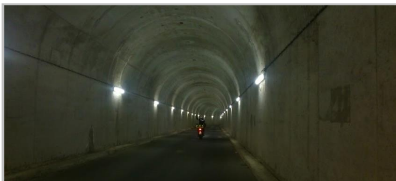
Εικόνα 90: Οδική σήραγγα πλησίον ΥΗΕ Πλατανόβρυσης (ΦΡΑΓΜΑ ΠΛΑΤΑΝΟΒΡΥΣΗΣ - Χάρτες Google)
