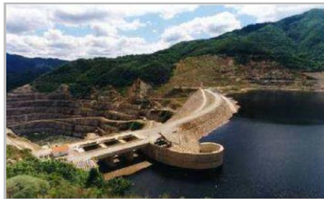
Εικόνα 80: Γενική άποψη του φράγματος ΥΗΕ Θησαυρού (Φωτογραφίες ΥΗΕ Θησαυρού - https://www.google.com/maps )
