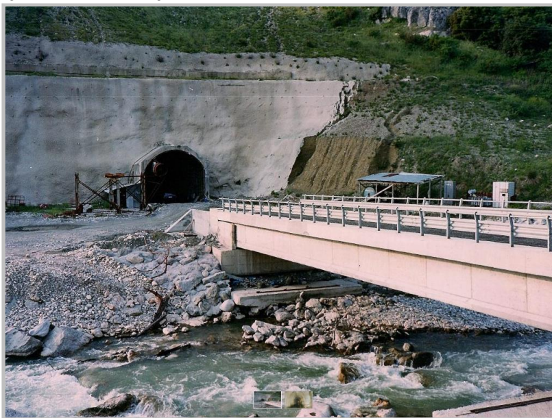
Εικόνα 49: Είσοδος σήραγγας ΥΗΕ Μετσοβίτικου (Σήραγγες – Michaniki)
