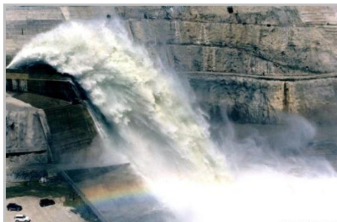
Εικόνα 81: Φρέαρ αναπήδησης εκχειλιστή ΥΗΕ Θησαυρού σε λειτουργία (Φωτογραφίες ΥΗΕ Θησαυρού - https://www.microhydropower.gr )
