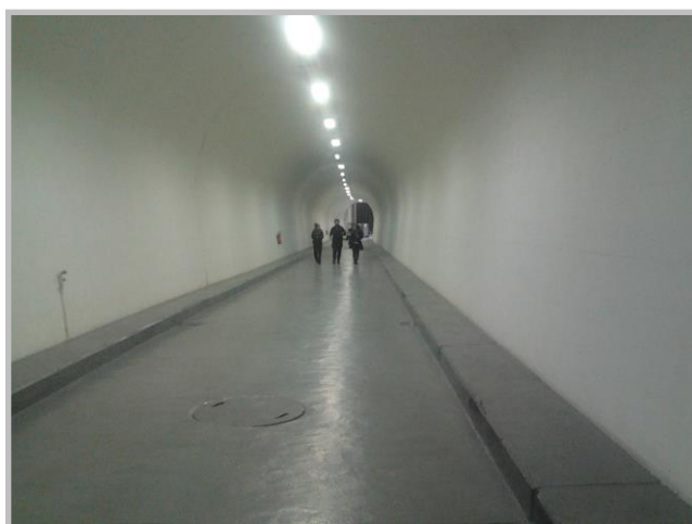
Εικόνα 69: Σήραγγα πρόσβασης στον ΥΗΣ Πολύφουτου (Φωτογραφίες ΥΗΕ Πολύφουτου, https://lengen.gr/el/2017/06/12/ελληνικά-επίσκεψη-υδροηλεκτρικός-στ/ )
