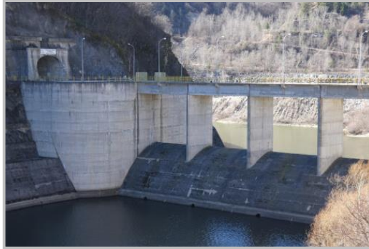
Εικόνα 77: Φράγμα ΥΗΕ Θησαυρού-είσοδος οδικής σήραγγας 52) (Φωτογραφίες ΥΗΕ Θησαυρού - https://www.google.com/maps )
