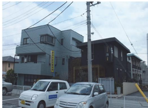
Σχήμα 1.4: Σπίτια που έχουν υποστεί καθίζηση και στρόφη (Yasuda et al., 2013)
