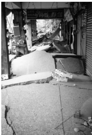
Σχήμα 1.1: Μετά από καθίζηση της θεμελίωσης, προέκυψε ανασήκωμα του εδάφους κατά 1 m (Chu et al., 2004)
