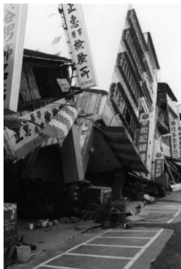
Σχήμα 1.2: Κτίριο που έχει ανατραπεί λόγω μεγάλης στροφής (Chu et al., 2004)
