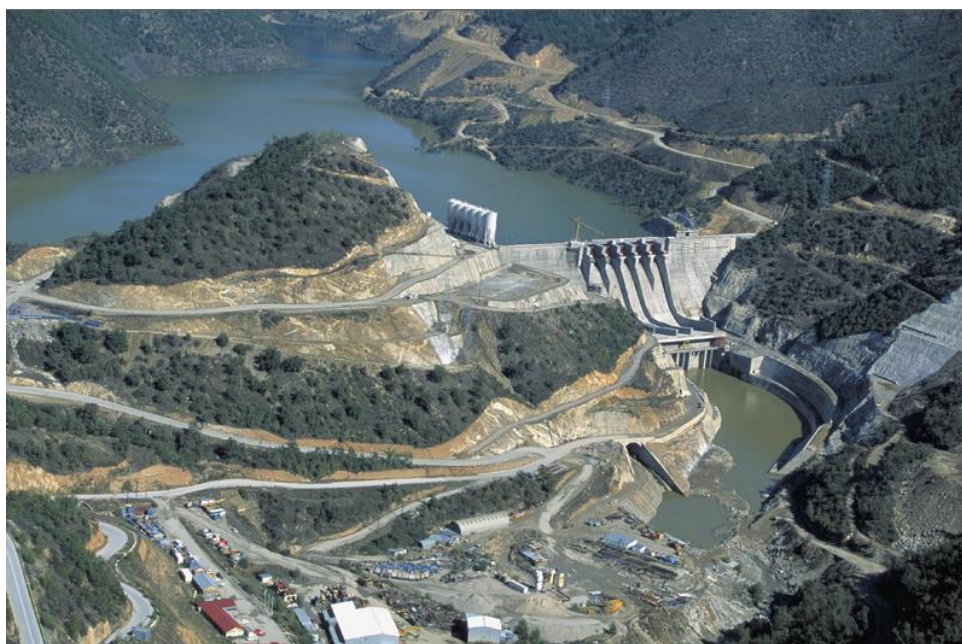
Σχήμα 5.10: Το φράγμα της Πλατανόβρυσης ( www.greekscapes.gr )
