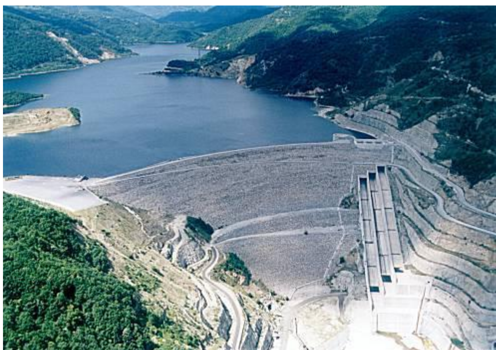
Σχήμα 5.9: Το φράγμα του Θησαυρού στον ποταμό Νέστο (Panoramio Photos, από Google Earth).
