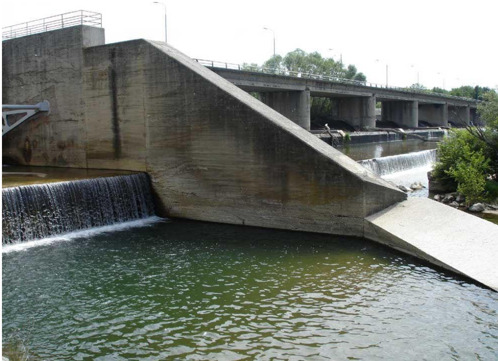
Σχήμα 5.7: Δυτικό κανάλι εκτροπής φράγματος Τοξοτών
