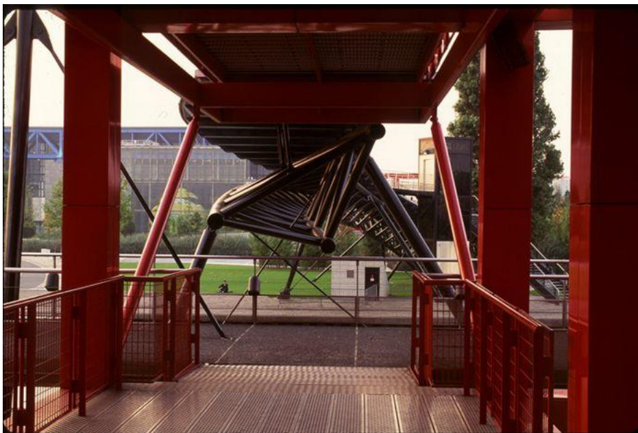
Εικόνα 34: άποψη των folies
