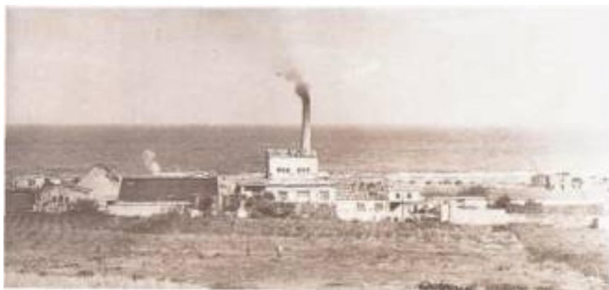
Εικόνα 2.9: Το εργοστάσιο της ΒΙΟ και οι ευρύτερη περιοχή της Καλλιθέας (1935)
