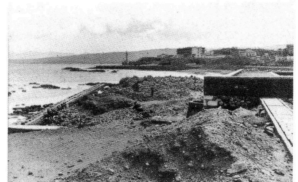
Εικ. 28: Εργασίες κατασκευής του κολυμβητηρίου
