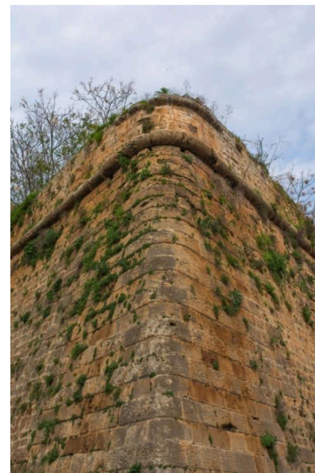
Εικ. 4: Η γωνία του προμαχώνα San Dimitri, με διακριτά το parapetto και το cordone
