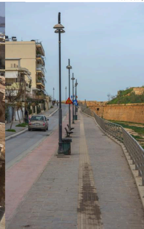
Εικ. 35: Διαμόρφωση πεζοδρόμου και ποδηλατόδρομου στην οδό Πειραιώς
