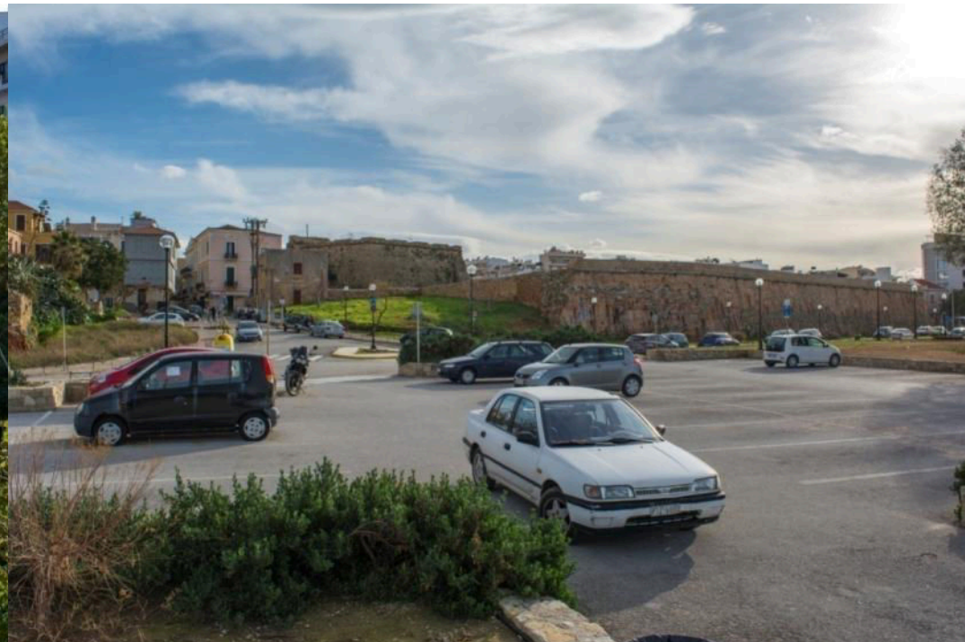
Εικ. 38: Ο προμαχώνας San Salvatore και μπροστά ο χώρος στάθμευσης της πλατείας Τάλω
