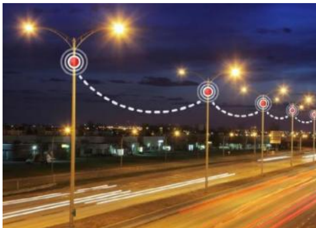
Εικόνα 10.11: Σύστημα διαχείρισης ηλεκτροφωτισμού με LEDs Πηγή: arta.gr
