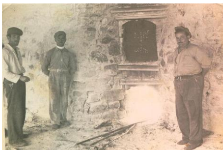
Εικόνα 9.3: Βιομηχανικά κτίρια εξόρυξης λευκόλιθου/μαγνησίτη, Πηγή: http://aei-project.ntua.gr
