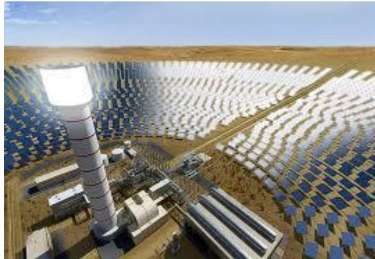
Εικόνα 11. Συγκεντρωτικό ηλιακό πάρκο
