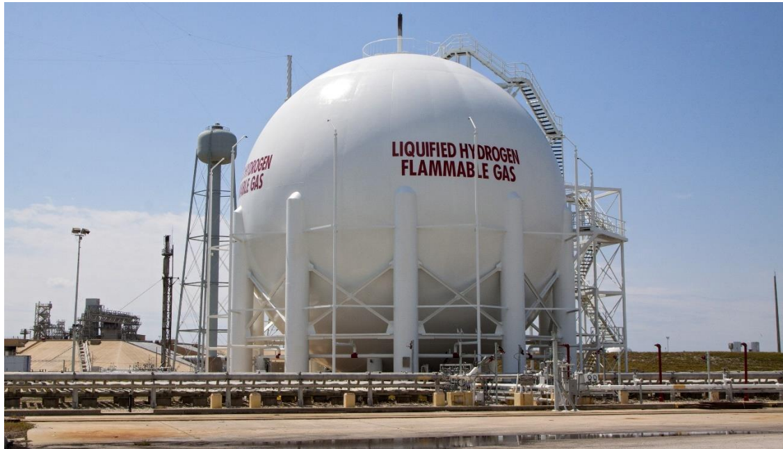
Εικόνα 29: Μονάδα Αποθήκευσης Υγρού Υδρογόνου.
