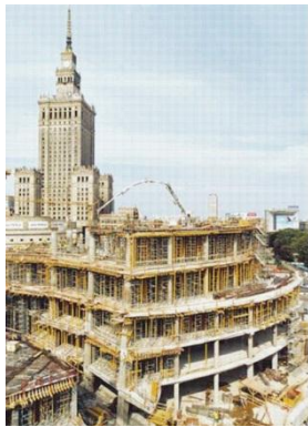
Εικόνα 1.5 Κατασκευή κτιρίου υψηλών προδιαγραφών, Βαρσοβία (Ιούνιος 2005).
