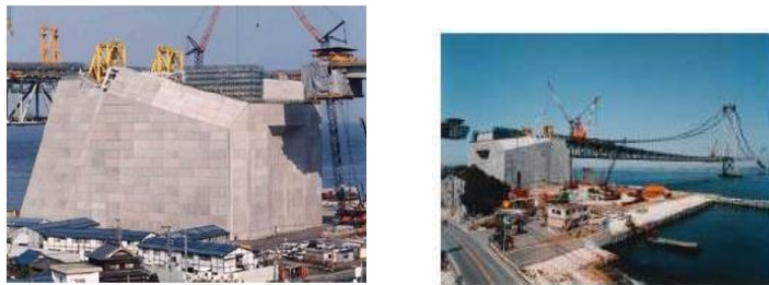
Εικόνα 1.3 Πλαϊνές όψεις βάσης αγκύρωσης της γέφυρας Akashi-Kaikyo κατά τη φάση της κατασκευής.
