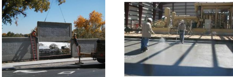
Εικόνα 1.9 (Αριστερά) Προκατασκευασμένα πάνελα από ΑΣΣ, Arvada, Colorado (2007 Louisiana Transportation Engineering Conference), (Δεξιά) Κατόπιν σκυροδέτησης πλάκας με ΑΣΣ απαιτείται ελάχιστη εργασία για επίτευξη καλής τελικής επιφάνειας.
