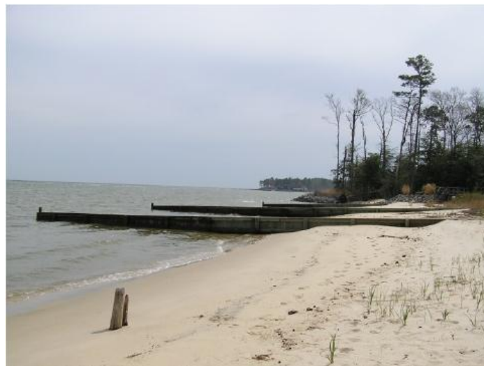
Εικόνα 2.2: Ξύλινοι πρόβολοι διαμορφωμένοι κάθετα στην ακτή
