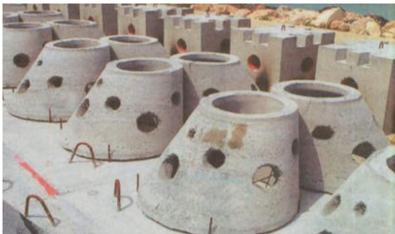
Εικόνα 2.9: TY κατασκευασμένοι από τσιμέντο όπως χρησιμοποιήθηκαν για τη δημιουργία του TY Πρέβεζας
