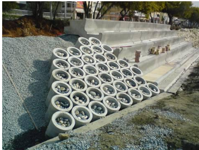
Εικόνα 2.6: Θωράκιση με σωληνωτά τεμάχια
