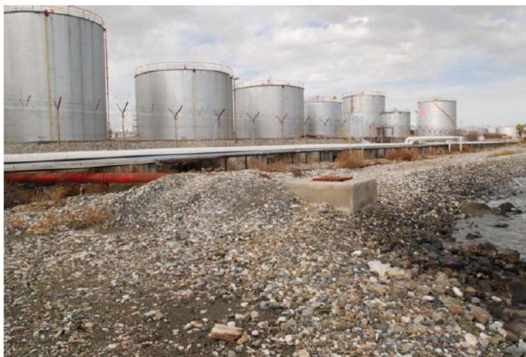
Εικόνα 4.6: Εγκαταστάσεις πετρελαιοειδών και διυλιστηρίου (δυτικό τμήμα υποπεριοχής 1)
