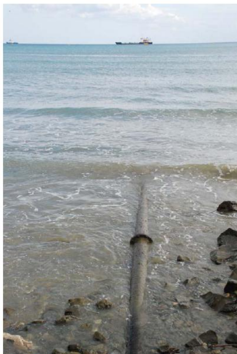
Εικόνα 4.23: Υποθαλάσσιος αγωγός μεταφοράς πετρελαϊκών προϊόντων
