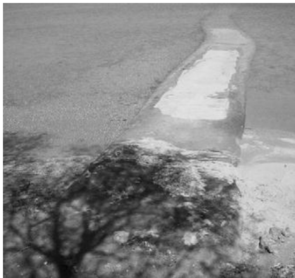
Εικόνα 2.7: Πυθμενικοί πρόβολοι – ήπια μέτρα προστασίας ακτών από τη διάβρωση
