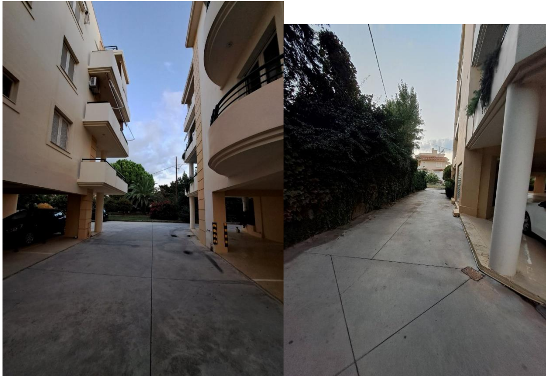
Εικόνα 6.22: Φωτογραφίες αυτοψίας στο ΟΤ 1379 όπου φαίνονται οι δίοδοι προς τον ΥΑΧ (Πηγή: Ιδία επεξεργασία)
