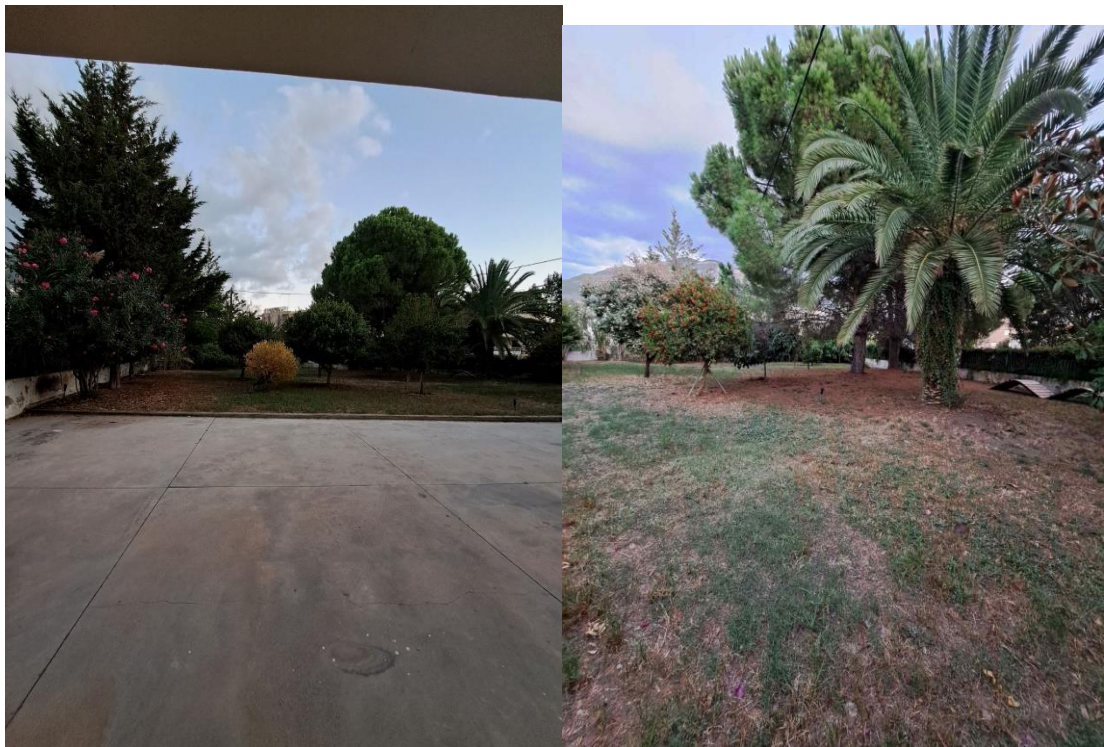
Εικόνα 6.23: Φωτογραφίες αυτοψίας στο ΟΤ 1379 όπου φαίνεται ο υλοποιημένος ΥΑΧ (Πηγή: Ιδία επεξεργασία)
