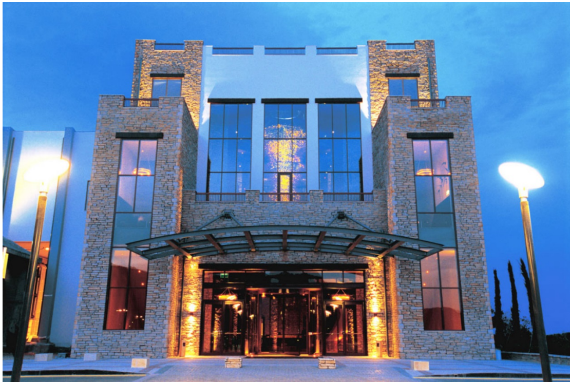
ΕΙΚΟΝΑ 20 ΚΑΤΩ ΣΤΑΘΜΟΣ ΤΗΛΕΦΕΡΙΚ ΠΑΡΝΗΘΑΣ
