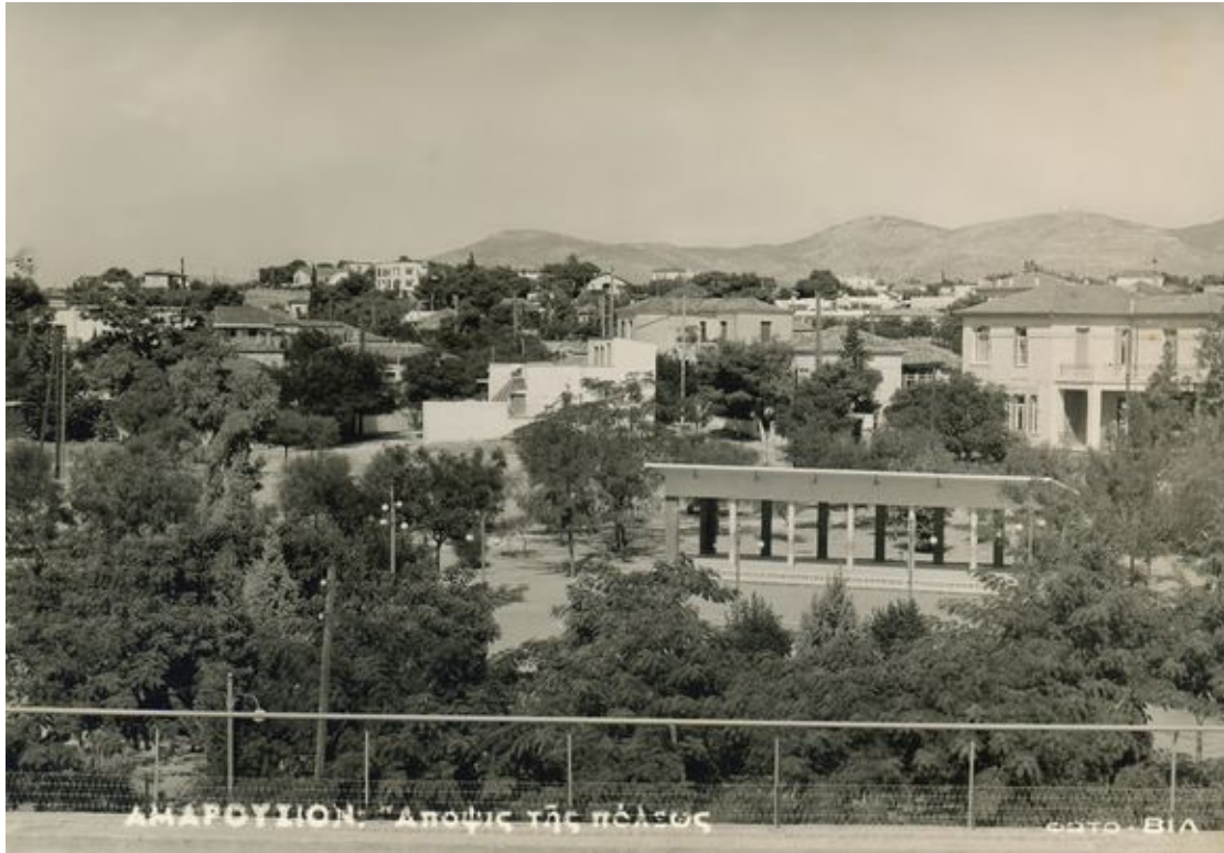
ΕΙΚΟΝΑ 33 ΆΠΟΨΗ ΑΠΟ ΤΟΝ ΗΛΕΚΤΡΙΚΟ ΣΤΑΘΜΟ ΑΜΑΡΟΥΣΙΟΥ ΤΗΣ ΠΛΑΤΕΙΑΣ ΓΑΡΔΕΛΗ ΑΘΗΜΟΝΙΟΝVIMA.GR
