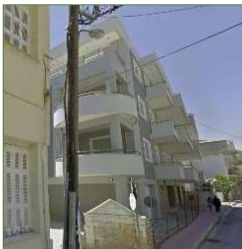
Εικόνα 182| Ανέγερση νέας οικοδομής τεσσάρων ορόφων στην οδό Περρούκα, δίπλα σε κηρυγμένη κρήνη, κατόπιν αποχαρακτηρισμού του προϋπάρχοντος κτηρίου
