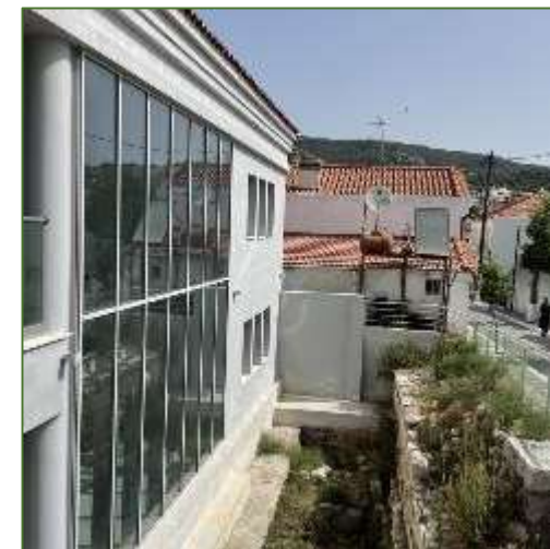
Εικόνα 63| Δημοτικό Κτήριο συμβατικών μορφολογικών και οικοδομικών στοιχείων από οπλισμένο σκυρόδεμα, σε οικόπεδο με εμφανή αρχαιολογικά κατάλοιπα και σε παραδοσιακό οικισμό, Σάμος (Προσωπικό Αρχείο, 07.2024)
