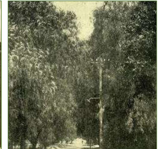
Εικόνα 121| Αποψη οδού Δαναού, δενδροφυτεμένη (Αργολική Αρχαιακή Βιβλιοθήκη)
