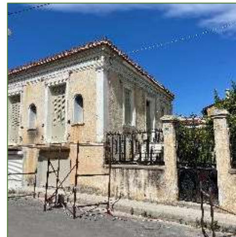
Εικόνα 122| Αυλή κατοικίας, οδού Τσώκρη 98 (Προσωπικό Αρχείο, 04.2024)
