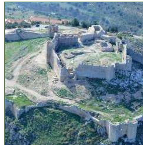
Εικόνα 100| Αποψη Κάστρου Λάρισας (Πηγή: ΕΦΑ Αργολίδας)
