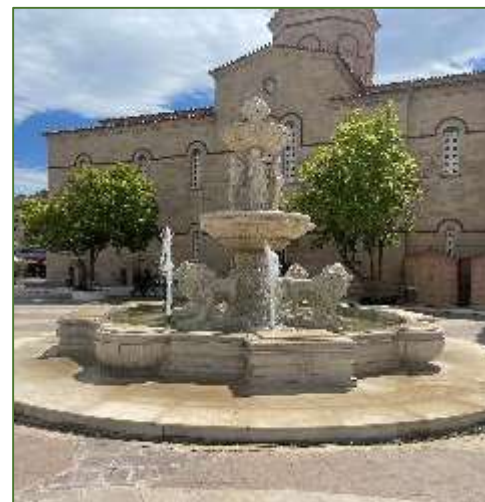
Εικόνα 165| Τοποθέτηση σιντριβανιού στην Πλατεία Αγίου Πέτρου (Προσωπικό Αρχείο, 04.2024)
