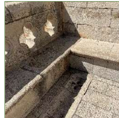
Εικόνα 37| Δίκτυο απορροής ομβρίων, Ντουμπρόβνικ (Προσωπικό Αρχείο, 08.2023)
