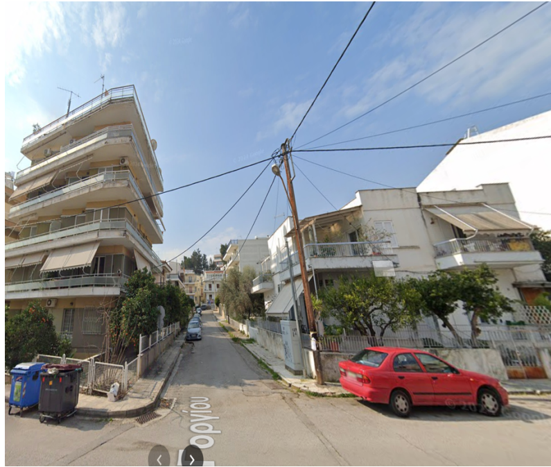
Εικόνα 5.12. Προσφυγική γειτονιά στη βοιωτική ακτή με Σ.Δ. 1,2 και λήψη στη συμβολή των οδών Αργυροκάστρου και Γοργίου – Google Maps
