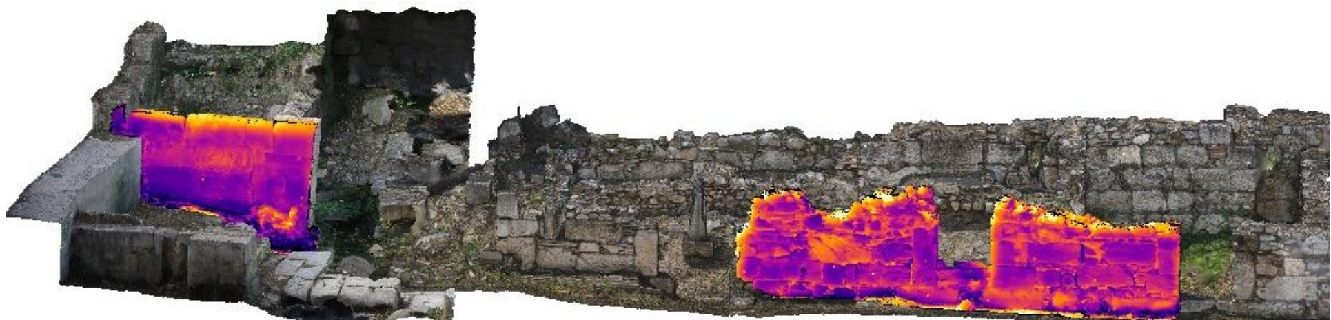
Εικόνα 5.73: Τρισδιάστατο μοντέλο με υφή Θερμογραφίας Υπερύθρου
