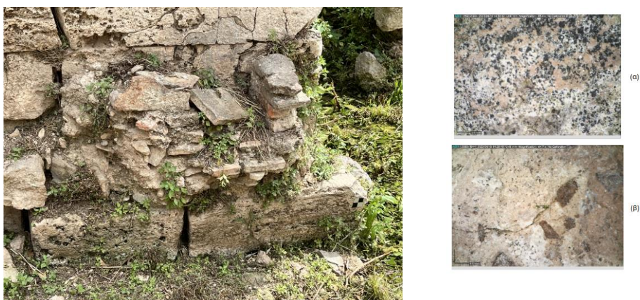
Εικόνα 5.18: Μακροσκοπική εικόνα για Τοιχίο 1, πλίνθοι 13 και εικόνες DM
