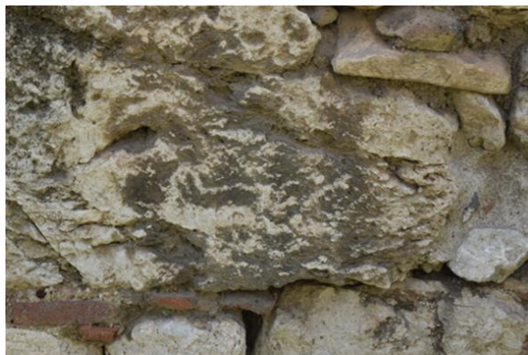
Εικόνα 4.166: Παράδειγμα κρούστας, περιοχή ΤΧ2 λίθος 8
