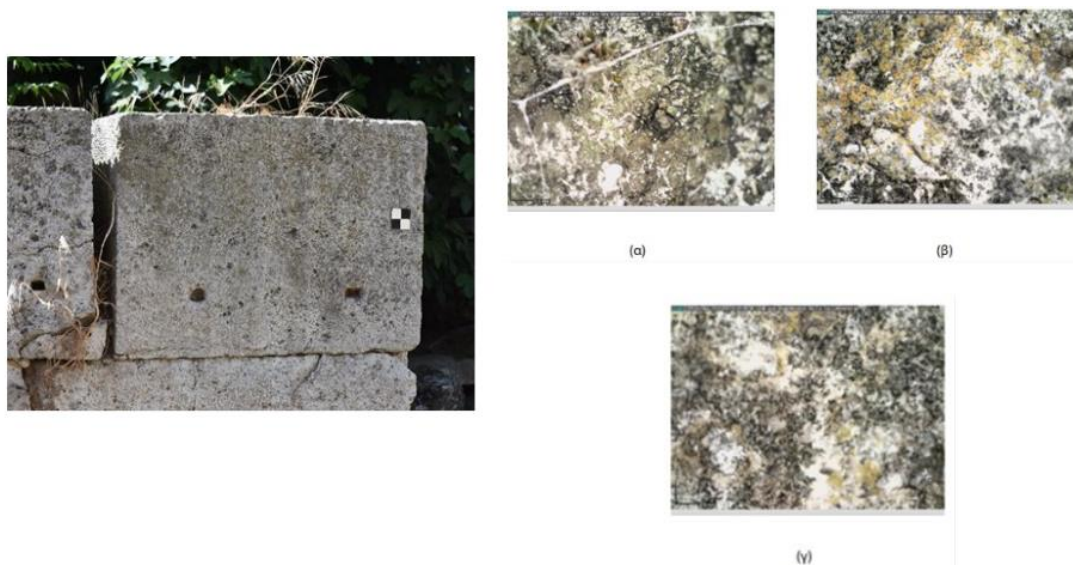
Εικόνα 5.6: Μακροσκοπική εικόνα για Τοιχίο 1, λίθο 3 και εικόνες DM
