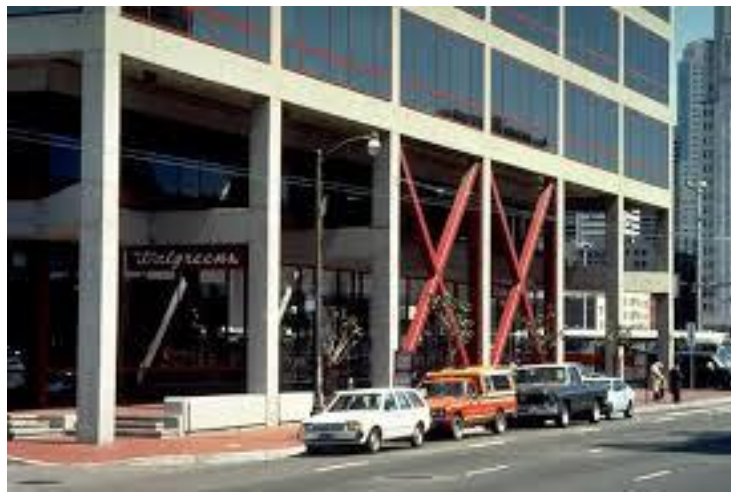
Εικόνα 6-6: Παράδειγμα χιαστί συνδέσμων δυσκαμψίας σε υφιστάμενο κτίριο
