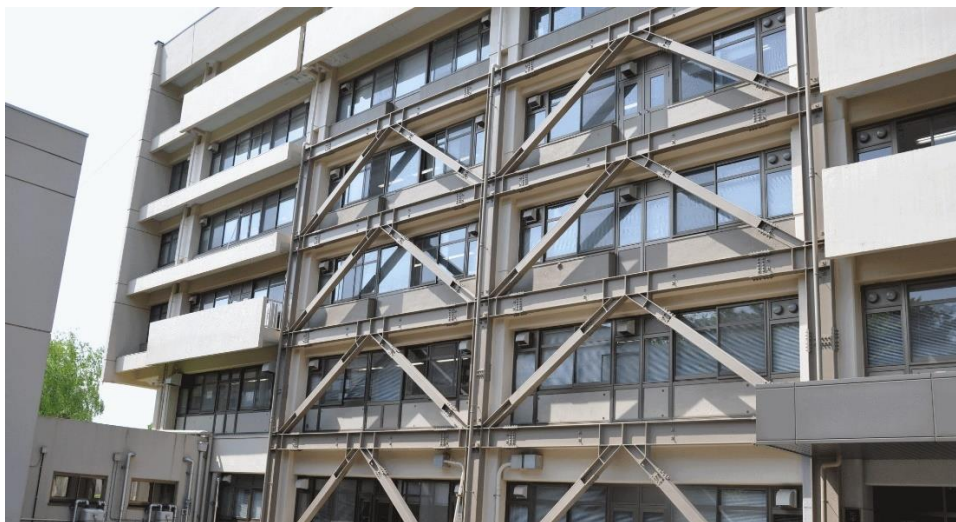
Εικόνα 6-7: Παράδειγμα συνδέσμων τύπου Λ σε υφιστάμενη κατασκευή
