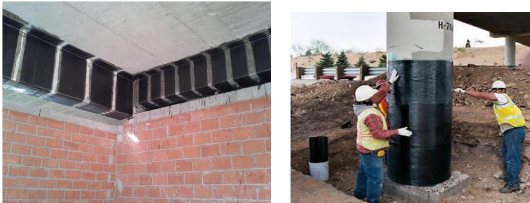
Εικόνα 6-11: Παραδείγματα περίσφιξης με ΙΟΠ σε υφιστάμενες κατασκευές
