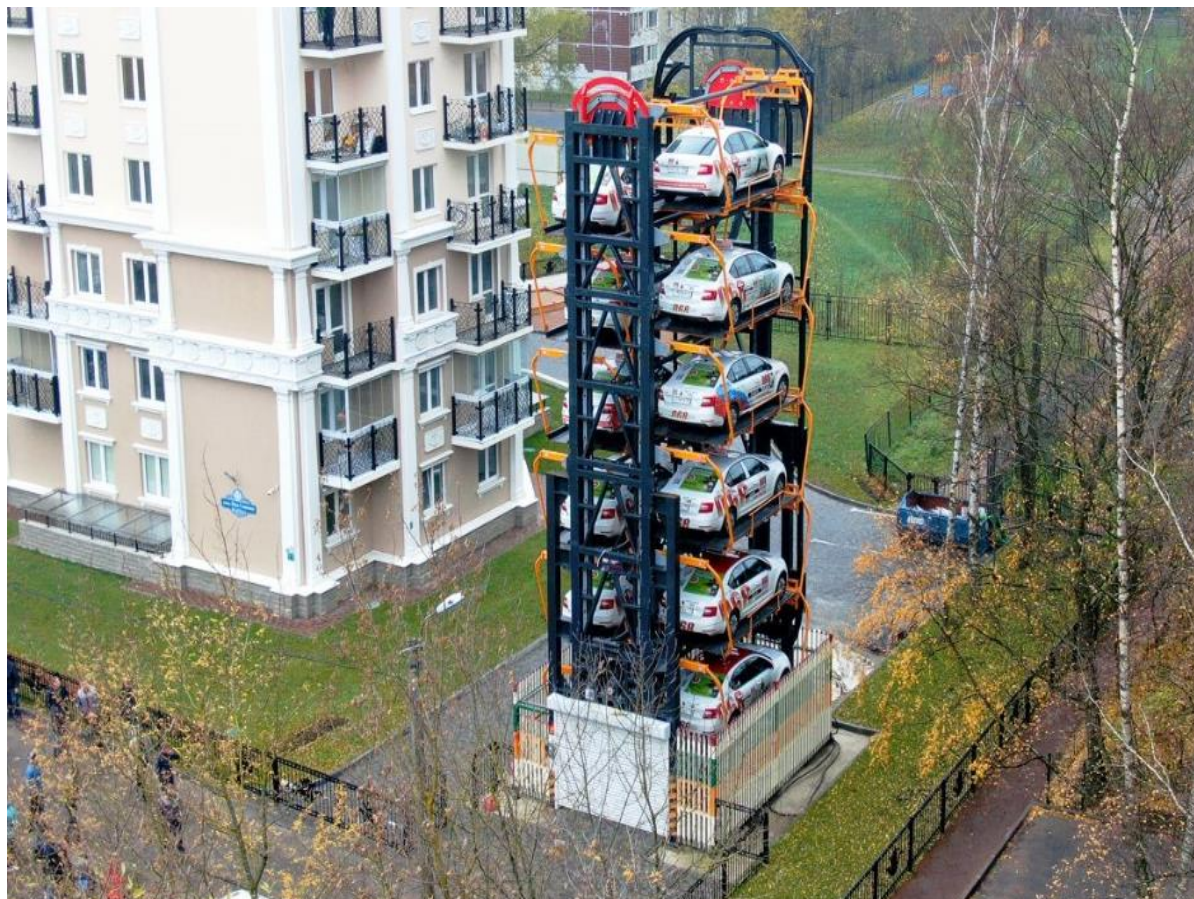
Σχήμα 6.5: Αυτόματο περιστροφικό σύστημα στάθμευσης ( Πηγή : www.mutrade.com ).
