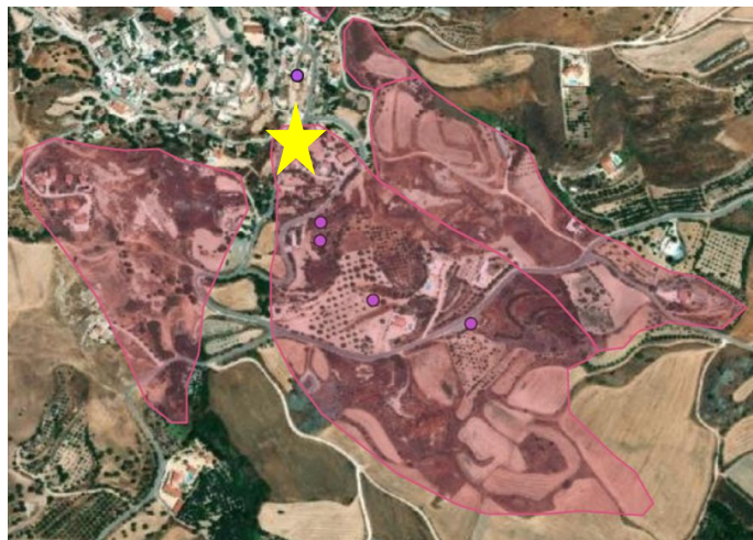
Εικόνα 20. Προβλήματα σε κτήρια που βρίσκονται στο φρύδι της κατολίθησης
