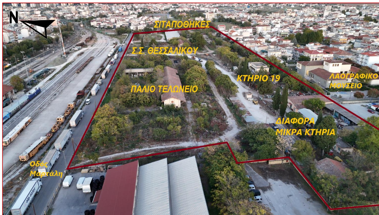
Φωτ. 4.3.2.14 – Η περιοχή παλιού τελωνείου, κοιτώντας δυτικά. Εικόνα από drone / Ίδια επεξεργασία
