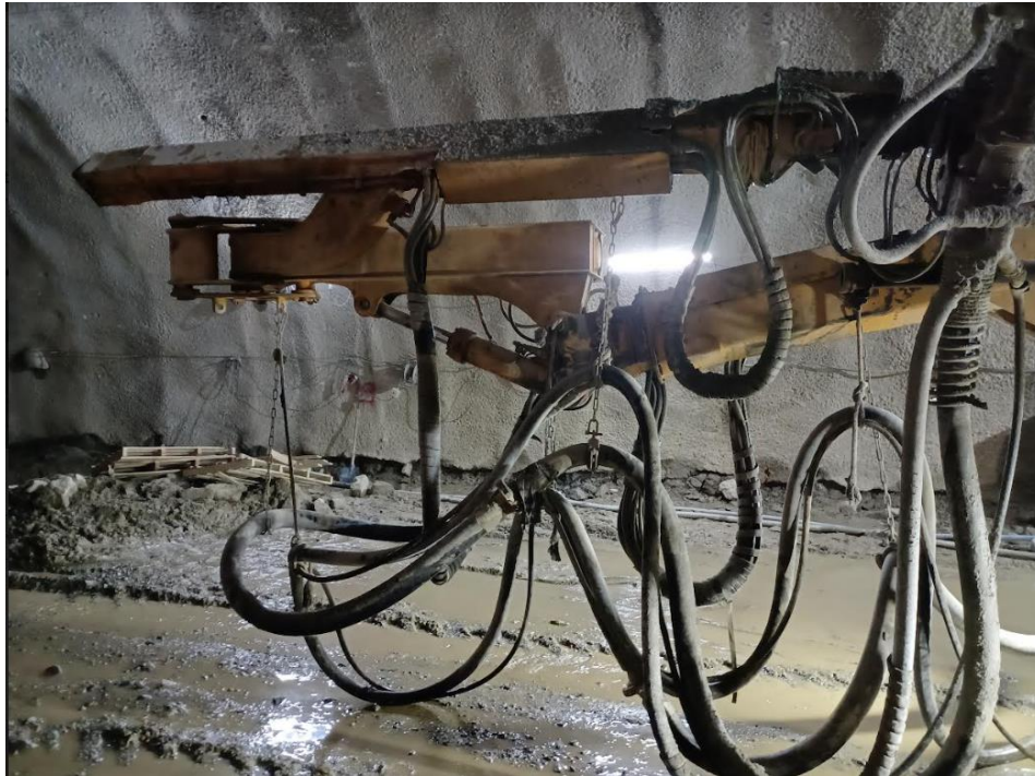
Εικόνα 2. 7: Μηχανή με την οποία γίνεται η εκτόξευση του σκυροδέματος (προσωπικό αρχείο).
