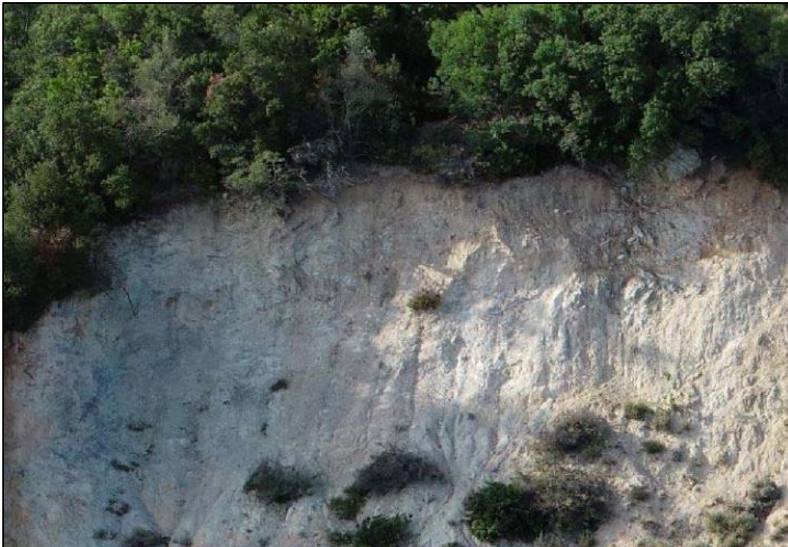
Εικόνα 4. 7: A3 Ισχυρά Κερματισμένη – Διαταραγμένη Ασβεστολιθική βραχομάζα, έντονα τεκτονισμένη (κατακερματισμένη) και μετρίως αποσαθρωμένη σε θέση εκδήλωσης αστάθειας (περί Χ.Θ. 2+600).
