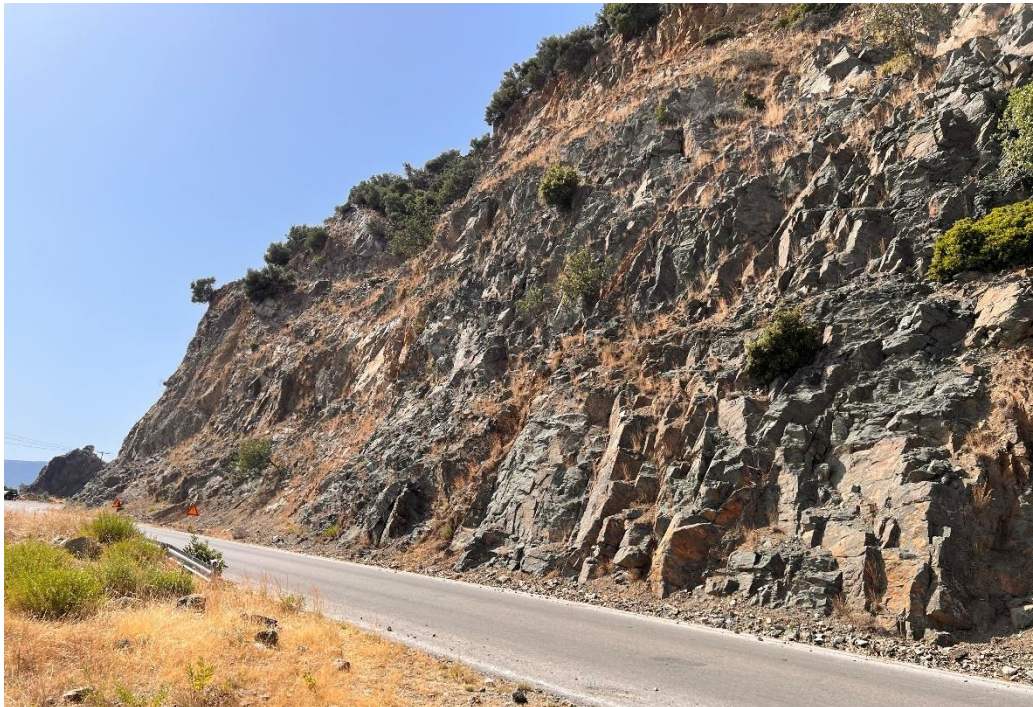
Εικόνα 1. 4: Ενδεικτικό πρανές της περιοχής έρευνας σε σχηματισμό πρασινιτών – πρασινοσχιστολίθων στο οποίο παρουσιάζεται η δομή, Πολύ Τεμαχώδης, του συγκεκριμένου γεωλογικού σχηματισμού.
