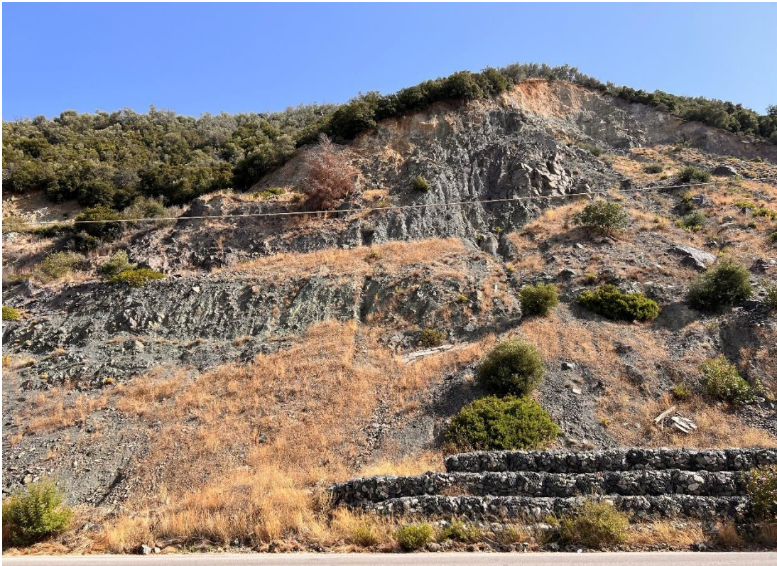
Εικόνα 1. 5: Κατολίσθηση ύψους περίπου 100m και πλάτους περίπου 110m η οποία εξελίσσεται περί την Χ.Θ. 3 + 400. Στη βάση του πρανούς έχει συσσωρευθεί εδαφικό υλικό καθώς και μικρά τεμάχια άρρηκτου βράχου.
