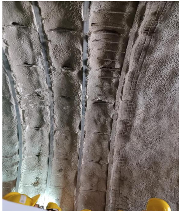
Εικόνα 2. 9: Χαλύβδινα πλαίσια πλατύπελμης διατομής (προσωπικό αρχείο).
