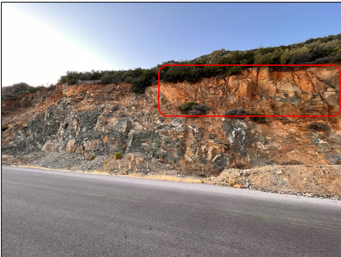
Εικόνα 4. 6: A2 Πολύ Τεμαχώδης Ασβεστολιθική βραχομάζα ελαφρώς αποσαθρωμένη και μερικώς διαταραγμένη. Διακρίνονται τμήματα τα οποία έχουν αστοχήσει είτε λόγω ανατροπής είτε με την δημιουργία σφηνών (περί Χ.Θ. 1+500).
