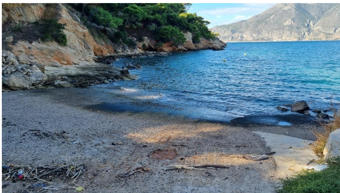
Εικόνα 4-52. Κεκλιμένο επίπεδο ανέλκωσης-καθέλκωσης σκαφών (ράμπα) λιμένα Αγίου Βασιλείου, ίδια φωτογράφιση.
