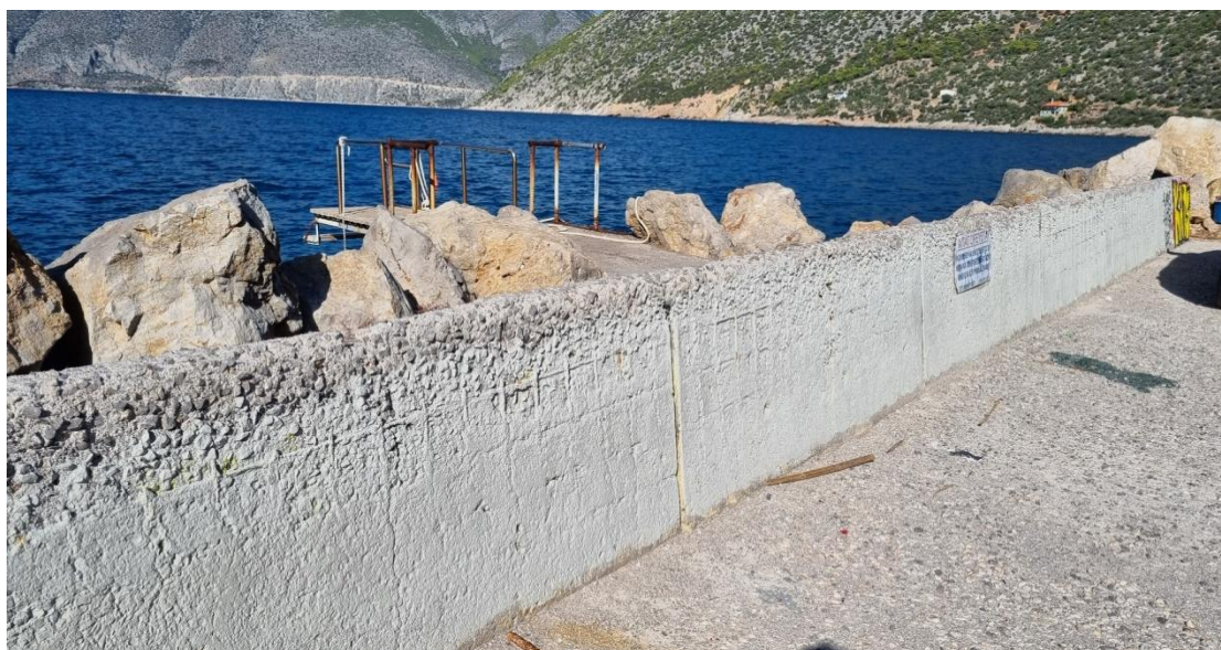
Εικόνα 4-50. Λιθορριπή φυσικών ογκολίθων και προφυλακτήριος τοίχος λιμένα Αγίου Βασιλείου, ίδια φωτογράφιση.
