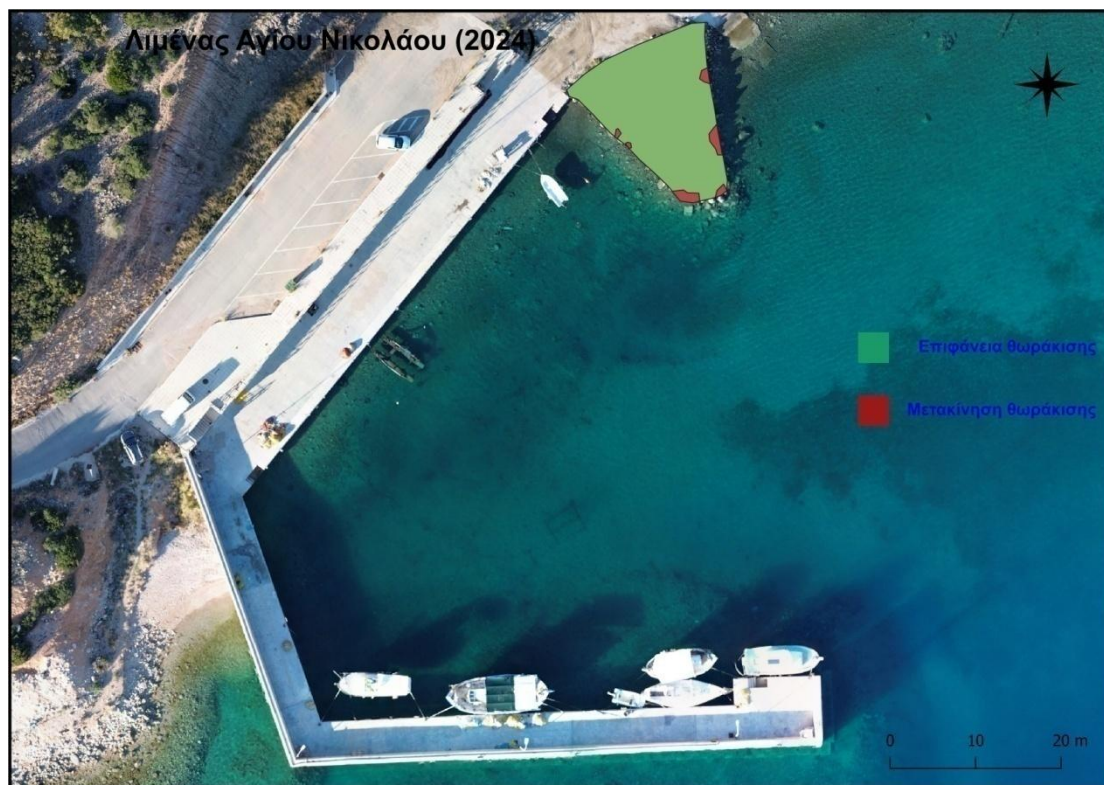
Εικόνα 6-126. Αποτύπωση Λιμένα 2-Άγιος Νικόλαος έτους 2024 ως προς την παράμετρο T.9: Μετακίνηση ογκολίθων θωράκισης έργου προστασίας.
