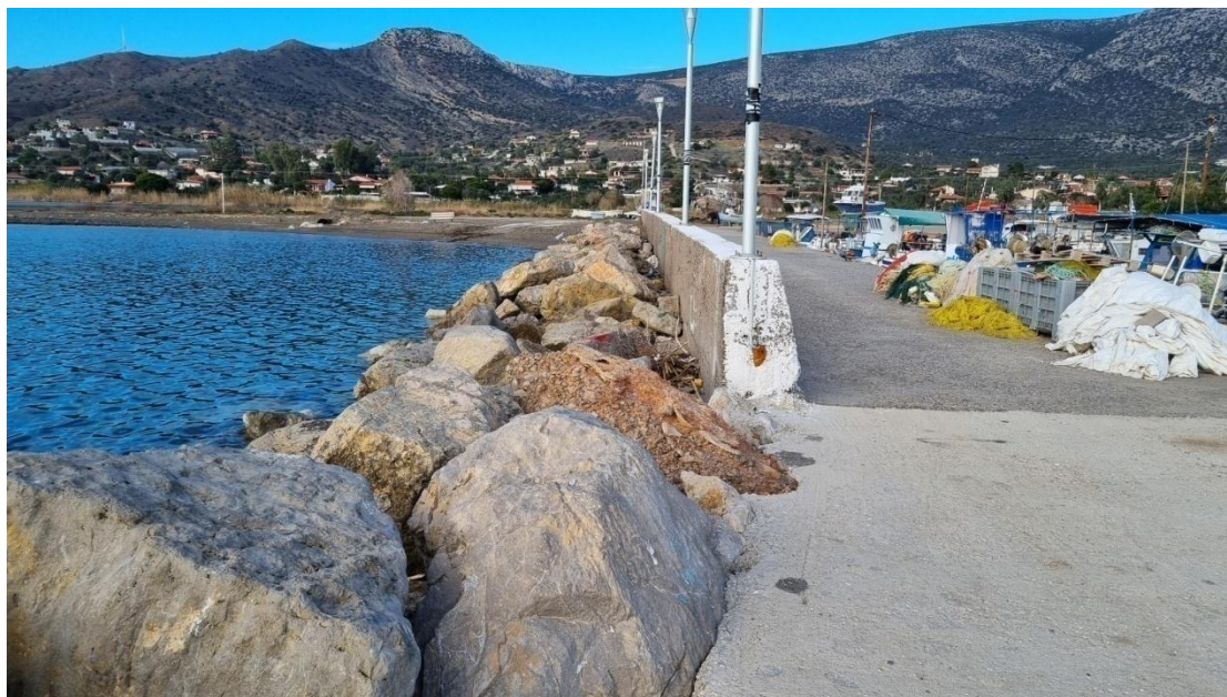
Εικόνα 4-26. Ενίσχυση προφυλακτήριου τοίχου με φυσικούς ογκόλιθους, ίδια φωτογράφιση.
