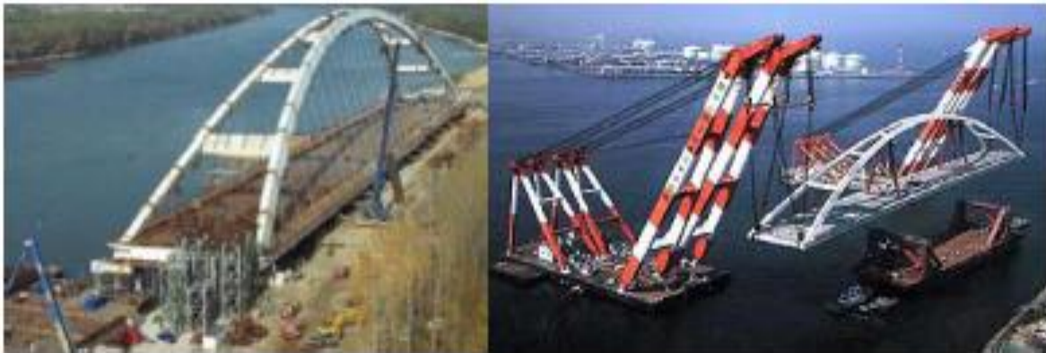
Σχήμα 1.6 Ανέγερση γέφυρας Pentele (2007)
