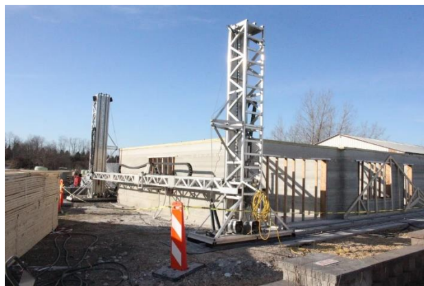
Σχήμα 2-4. Παράδειγμα 3D concrete printing μεγάλης κλίμακας
