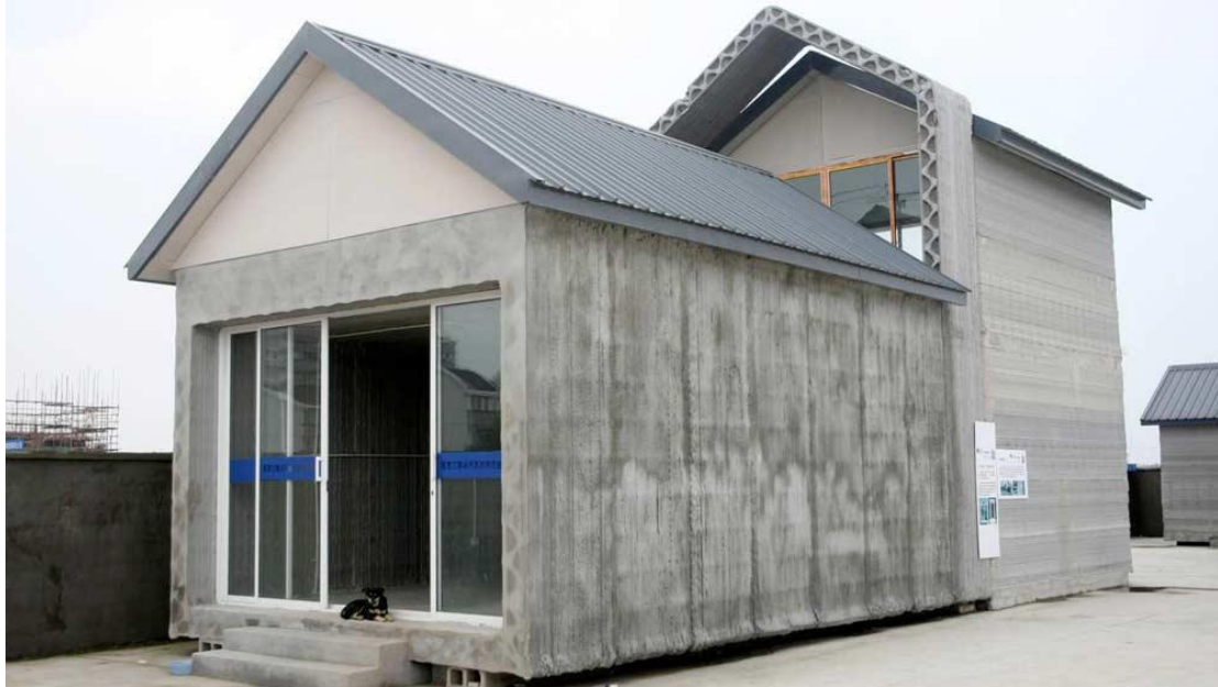
Σχήμα 3-2. Κατασκευή με τεχνολογία τρισδιάστατης εκτύπωσης από την εταιρεία WinSun
