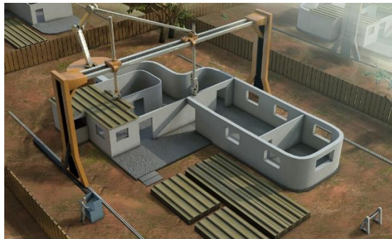
Σχήμα 2-2. Η μέθοδος Contour Crafting
