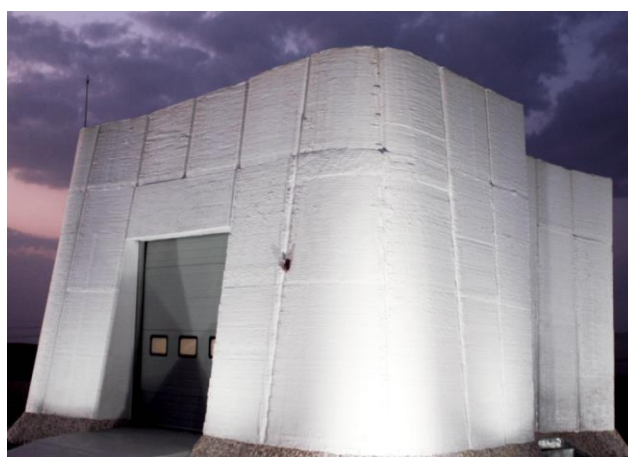
Σχήμα 5-2. (α) Ρομποτικός βραχίονας 3DCP της εταιρείας Cybe, (β) κατασκευή 3DCP
