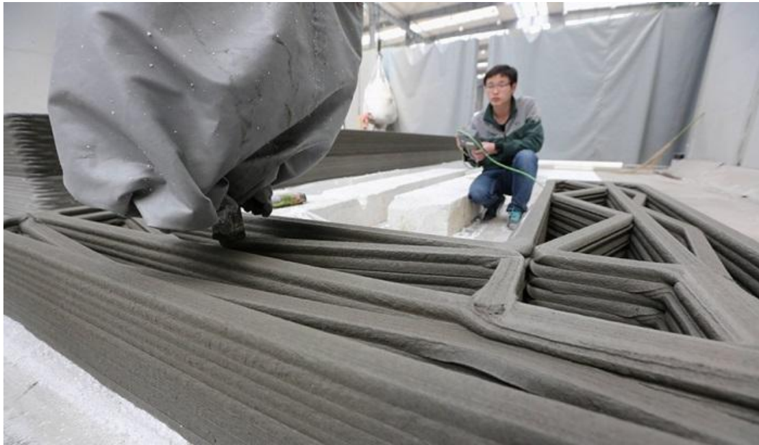
Σχήμα 3-3. Δοκιμαστικές ενέργειες τρισδιάστατης εκτύπωσης σε ερευνητικό στούντιο
