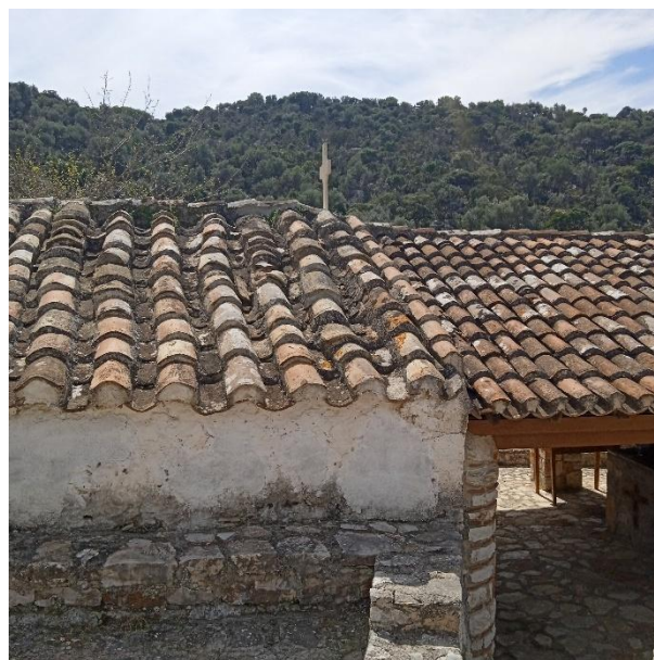
εικόνα 43, ίχνη ανερχόμενης υγρασίας από αναπήδηση ομβρίων στη βόρεια όψη
