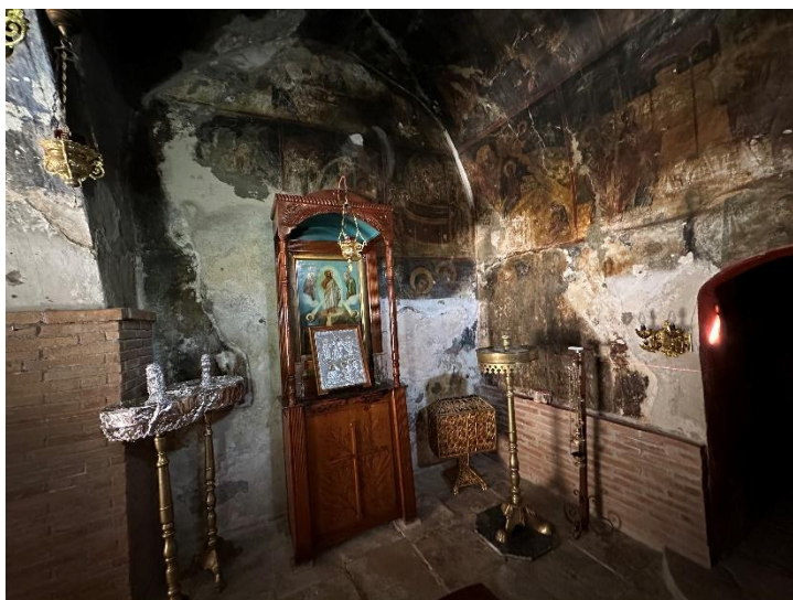
εικόνα 40, υγρασία βυθισμένου τμήματος κάτω από το έδαφος, φωτογραφία της Μ. Μπαλοδήμου
