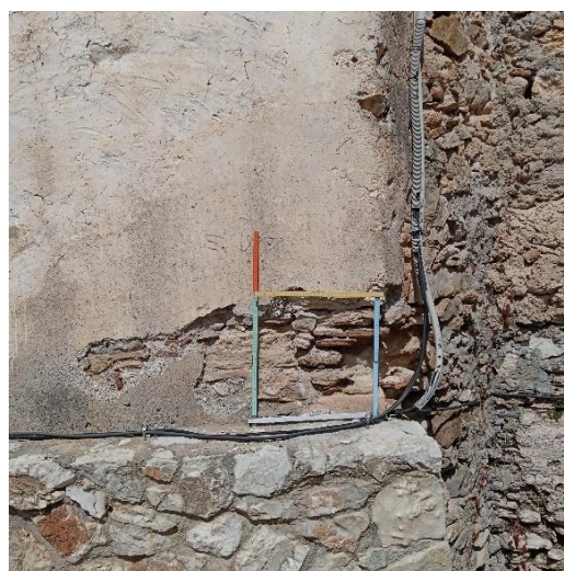
εικόνα 29, λεπτομέρεια στη νότια όψη
