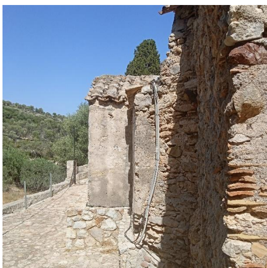
εικόνα 42, ίχνη ανερχόμενης υγρασίας από τις επεμβάσεις
