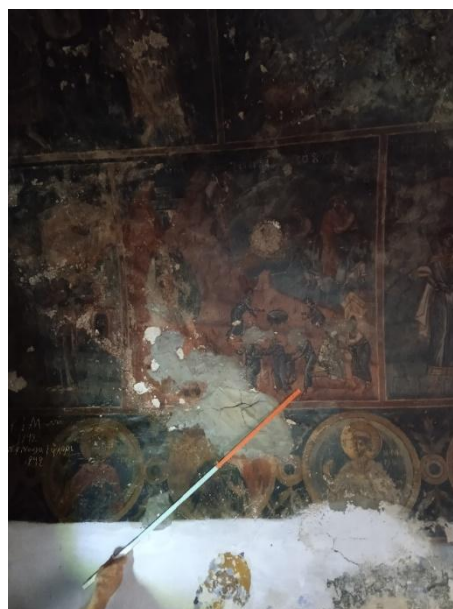
εικόνα 38, επέμβαση σε ρωγμή που έχει ρηγματωθεί εκ νέου εικόνα 39 (κάτω), επεμβάσεις με οπτόπλινθους, φωτογραφία της Μ. Μπαλοδήμου
