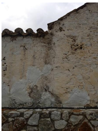
εικόνα 28, λεπτομέρεια στη νότια όψη
