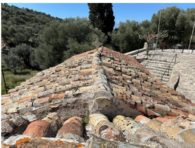
εικόνα 44, βιολογική φθορά κεραμιδιών
