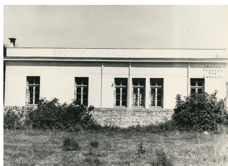
Εικ.2.2 Νοτιοανατολική όψη
