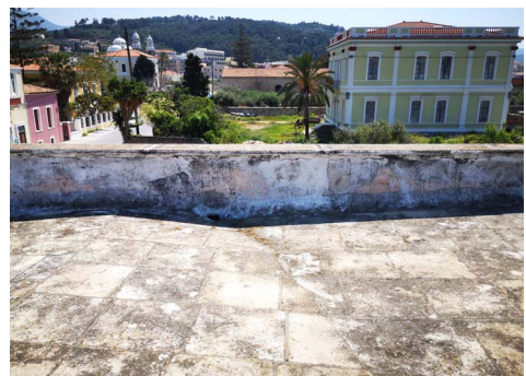
Εικ. 3.11 Δώμα με επίστρωση μαλτεζόπλακών_Πηγή: προσωπικό αρχείο
