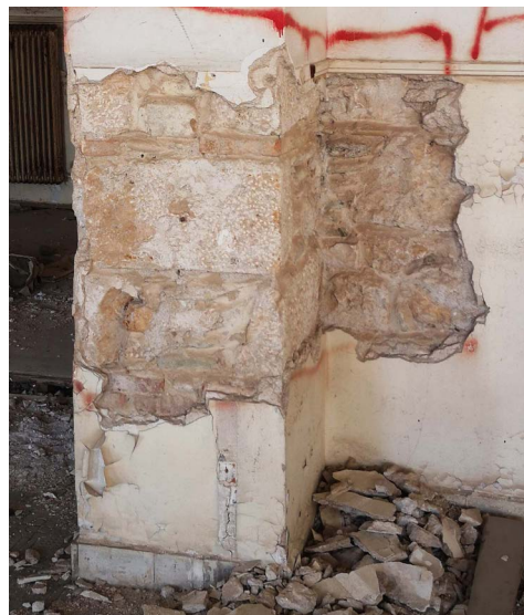
Εικ. 3.2 Οι λίθοι σε πεσσούς του ισόγειου _ Πηγή: προσωπικό αρχείο
