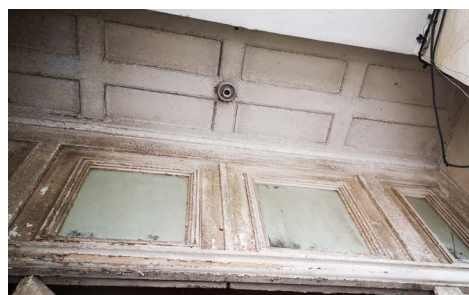
Εικ. 3.13 Ψευδοροφή εισόδου στο ισόγειο_ Πηγή: προσωπικό αρχείο
