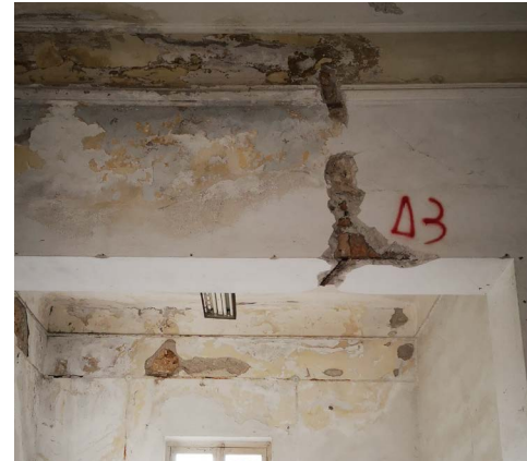
Εικ. 3.5 Μεταλλικό στοιχείο σε άνοιγμα-πέραςμα εσωτερικής τοιχοποιίας του ισογείου _ Πηγή: προσωπικό αρχείο
