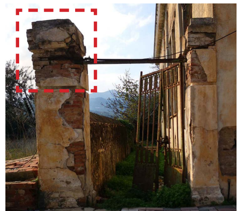
Εικ. 5.2 Αποκολλήσεις επιχρίσματος και μετατόπιση άνω μέρους κολόνας της αυλόθυρας_Πηγή: προσωπικό αρχείο
