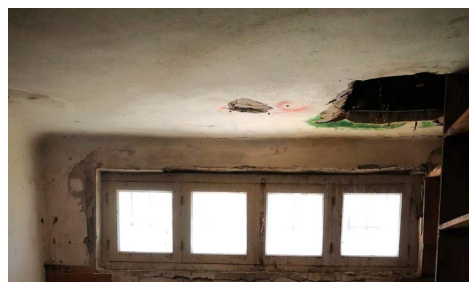
Εικ. 3.14 Οροφή πρώην γραφείου στον όροφο-δεξιά βρίσκεται η καταπακτή που οδηγεί στο δώμα_ Πηγή: προσωπικό αρχείο
