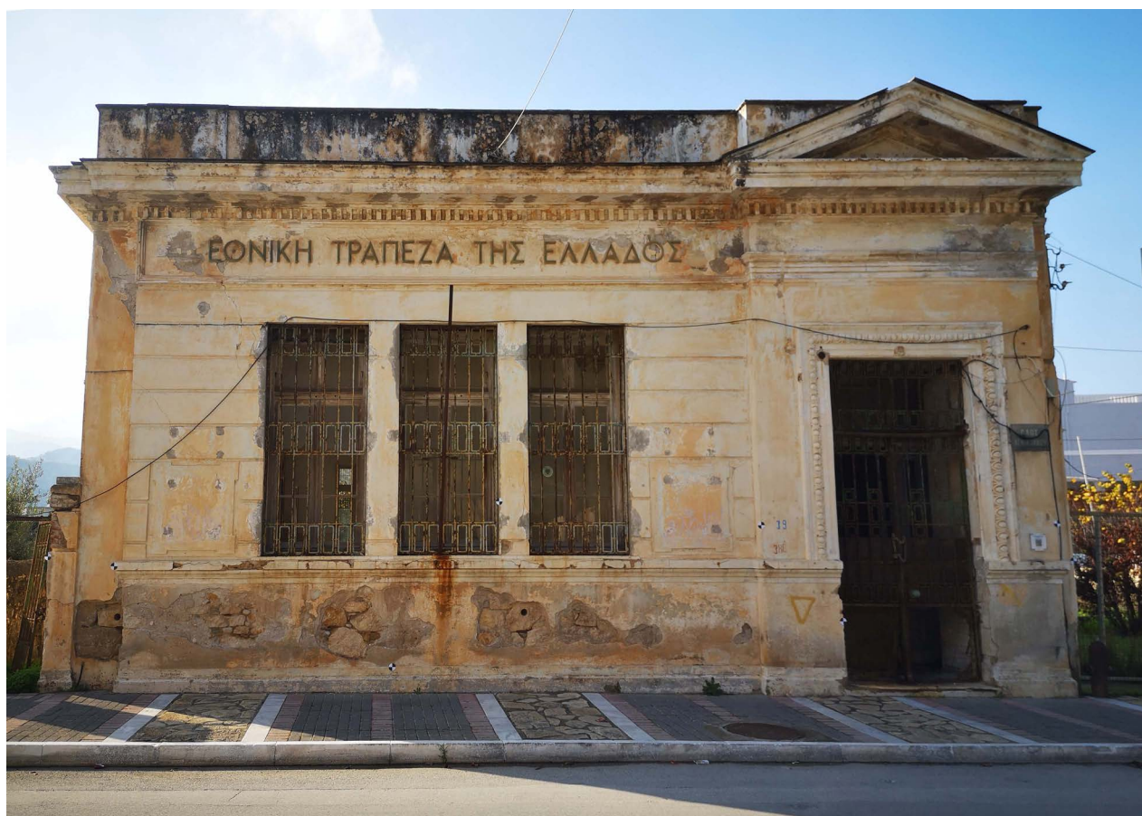
Εικ.2.5 Κύρια όψη κτηρίου_Πηγή: Προσωπικό αρχείο
