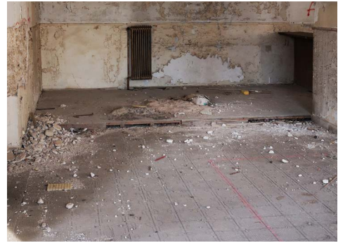
Εικ. 3.8 Δάπεδο ισογείου με τσιμέντινα πλακάκια και υπερυψωμένο ξύλινο δάπεδο_Πηγή: προσωπικό αρχείο
