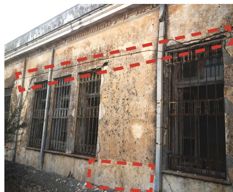
Εικ. 5.3 Τριχοειδείς διαγώνιες ρωγμές στις περιοχές ανάμεσα και κάτω από τα παράθυρα και οριζόντιες ρηγματώσεις πάνω από αυτά_Πηγή: προσωπικό αρχείο
