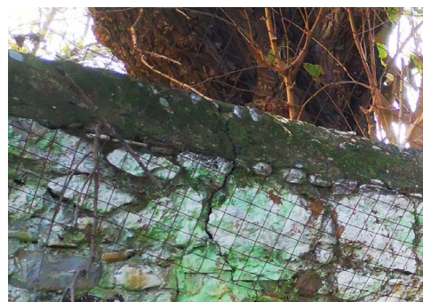
Εικ. 6.2., Εικ. 6.3 Βιολογική φθορά στην περίφραξη του οικοπέδου _Πηγή: προσωπικό αρχείο
