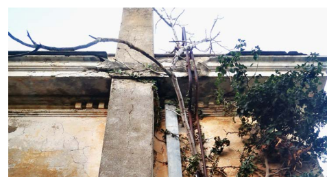
Εικ. 5.6 Παθολογία του γείσου της νοτιοδυτικής όψης_Πηγή: προσωπικό αρχείο
