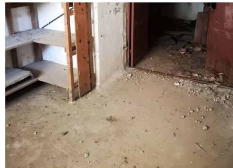
Εικ. 3.10 Δάπεδο υπογείου με επίστρωση τσιμεντοκονίας_Πηγή: προσωπικό αρχείο
