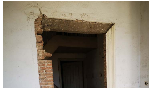
Εικ. 3.4 Πρέκι από σκυρόδεμα σε εσωτερική θύρα του ισογείου _ Πηγή: προσωπικό αρχείο
