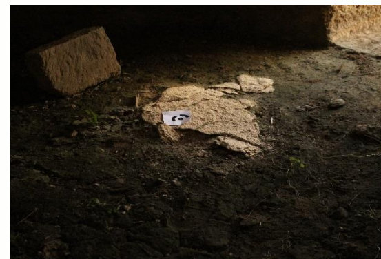
Εικόνα 32, Αποκόλληση επιφάνειας βράχου οροφής και λαξευμένος λίθος, Απρ. 2024, Προσωπικό αρχείο
