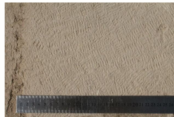
Εικόνα 42, Επεξεργασία επιφάνειας λίθινου δαπέδου, Προσωπικό αρχείο
