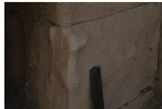
Εικόνα 49, Βαθιά διάβρωση στην εξωτερική δυτική ακμή του οστεοφυλακίου, Απρ. 2024, Προσωπικό αρχείο
