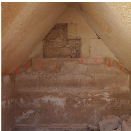
Εικόνα 18, Τάφος T.394, με κόκκινα βέλη σημειώνεται το επίπεδο της επιφάνειας που παρουσιάζει εξάνθιση αλάτων μετά την επίχωσή του, Απρ. 2024, Προσωπικό αρχείο
