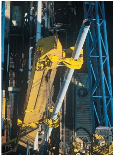
Εικόνα 3- 20. Γερανός φέρνει σε κατακόρυφη θέση τμήμα αγωγού, ‘J – lay’ μέθοδος. Πηγή: Gazprom.com
