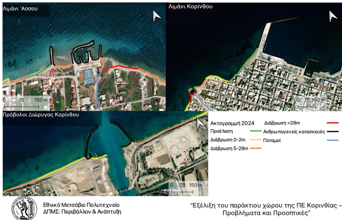
Εικόνα 4-11: Λιμάνια εντός της ΠΕ Κορινθίας και πρόβολοι στη διώρυγα της Κορίνθου Πηγή: Ιδία επεξεργασία
