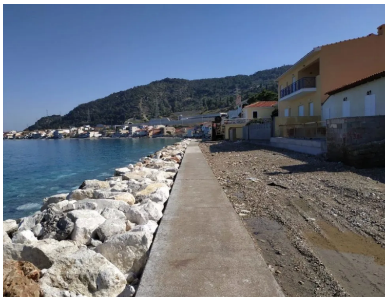
Εικόνα 4-5: Διαφραγματικός πασσαλότοιχος στην Αγία Τριάδα Δερβενίου Πηγή: Ενημέρωση Πελοποννήσου (2019)
