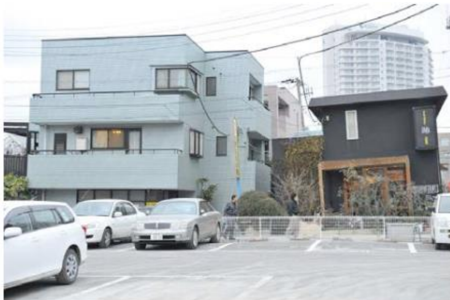
Σχήμα 2.4: Έντονα κεκλιμένο κτίριο μετά τον σεισμό Tohoku Pacific το 2011 (Tokimatsu et.al. 2013)
