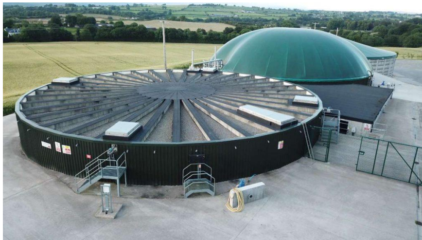
Σχήμα 26: Φωτογραφία των εγκαταστάσεων της εταιρίας Greenville Energy στην Ιρλανδία
