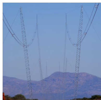
Σχήμα 1-6. α) Συνθετικοί μονωτήρες μακράς ράβδου σε διάταξη “cross-arm ασύμμετρο V-string” σε γραμμή 420 kV [17], β) συνθετικοί μονωτήρες μακράς ράβδου σε πυλώνα “chainette”.
