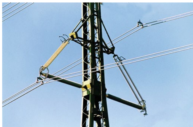
Σχήμα 1-9. Συνθετικοί μονωτήρες στήριξης τοποθετημένοι οριζόντια σε διάταξη σταυρωτού βραχίονα (cross-arm) [4].
