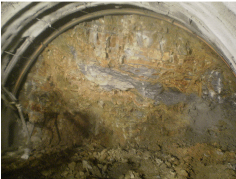
Εικόνα 15 : Μέτωπο γεωτεχνικής κατηγορίας C 2 στη Χ.Θ. 4+310,7 του δεξιού κλάδου
