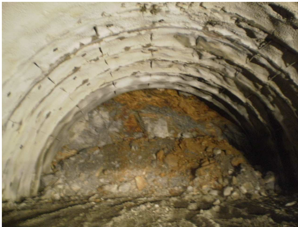
Εικόνα 19 : Μέτωπο γεωτεχνικής κατηγορίας C 1,2 στη Χ.Θ. 4+304 του αριστερού κλάδου
