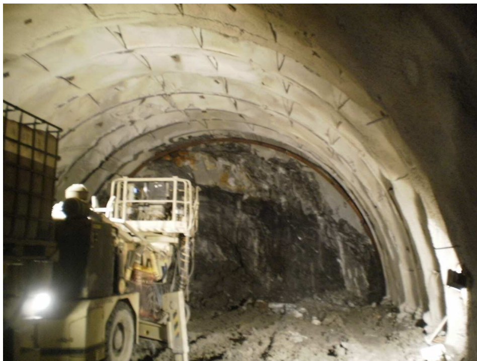
Εικόνα 14 : Προσωρινή υποστήριξη
