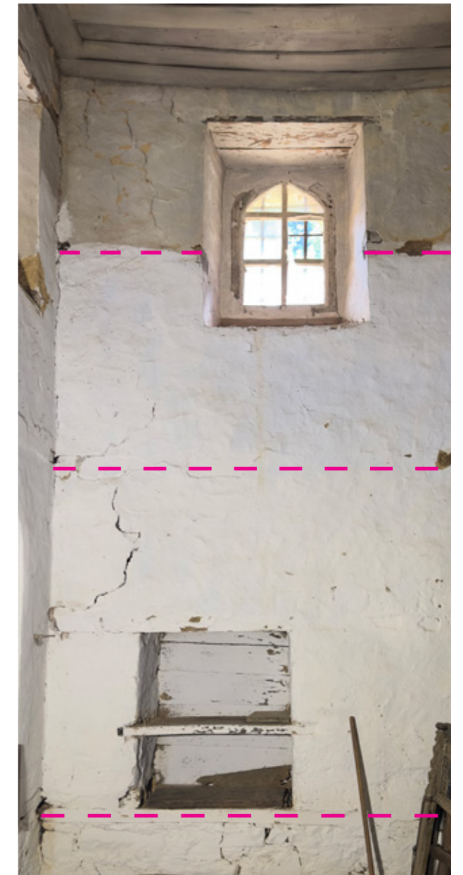
Εικ.112 | Ξυλοδεσιές στάθμες 2,3,4, Ν όψη. 08/2023.
