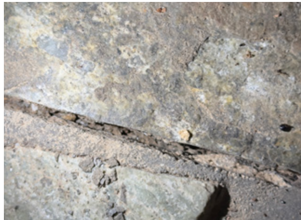
Εικ.142 | Το υπόστρωμα του νέου δαπέδου, μέσα από ρωγμή. 08/2024.
