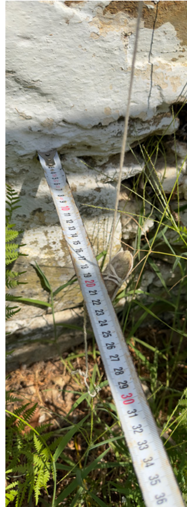
Εικ.175| Απόκλιση από την κάθετο με το νήμα της στάθμης, Δ όψη. 08/2023.
