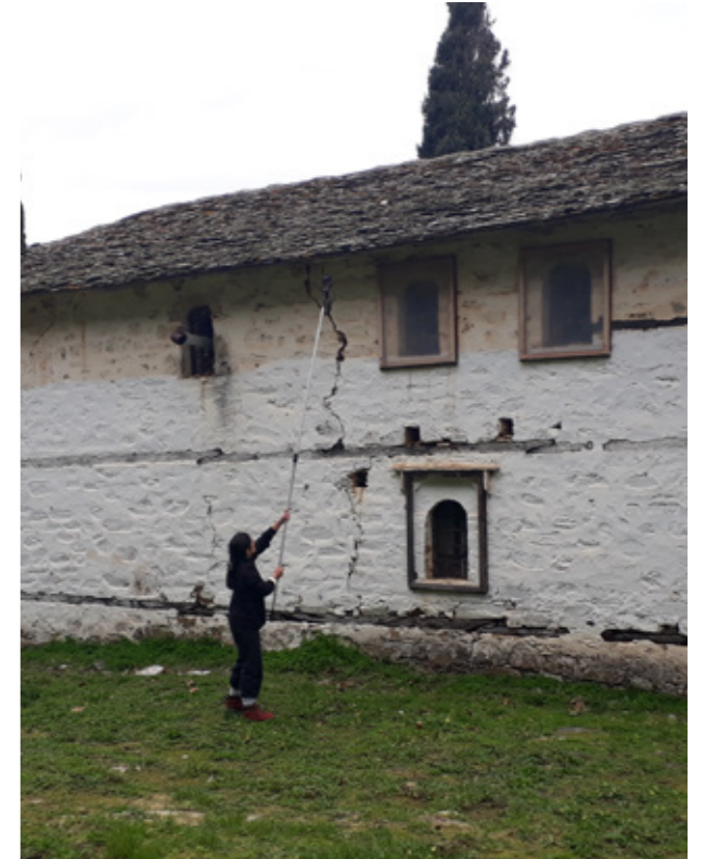
Εικ.10 | Φωτογράφιση της Ν όψης με πτυσσόμενο κοντάρι. 02/2024.
