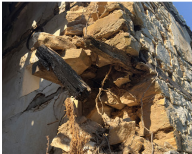
Εικ.250 | Βόρεια πτέρυγα, K111. Τρίστρωτη τοιχοποιία, διπλή ξυλοδεσιά. 08/2023.
