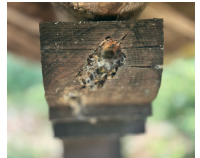
Εικ.221| Παθολογία ξύλινων τμημάτων του περιστώ. 08/2023.
