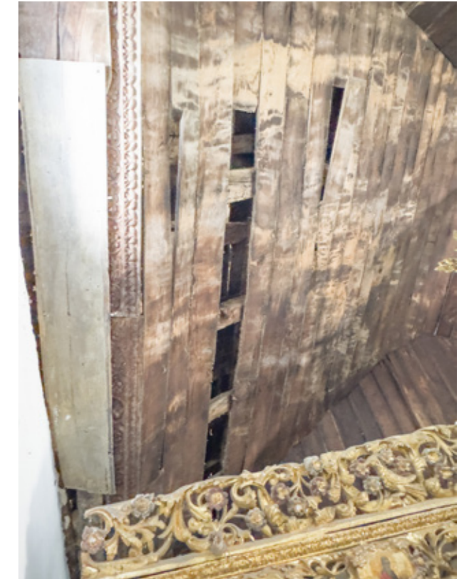
Εικ.145 | Τα πηγάκια στήριξης του ψευδοθόλου. 02/2024.
