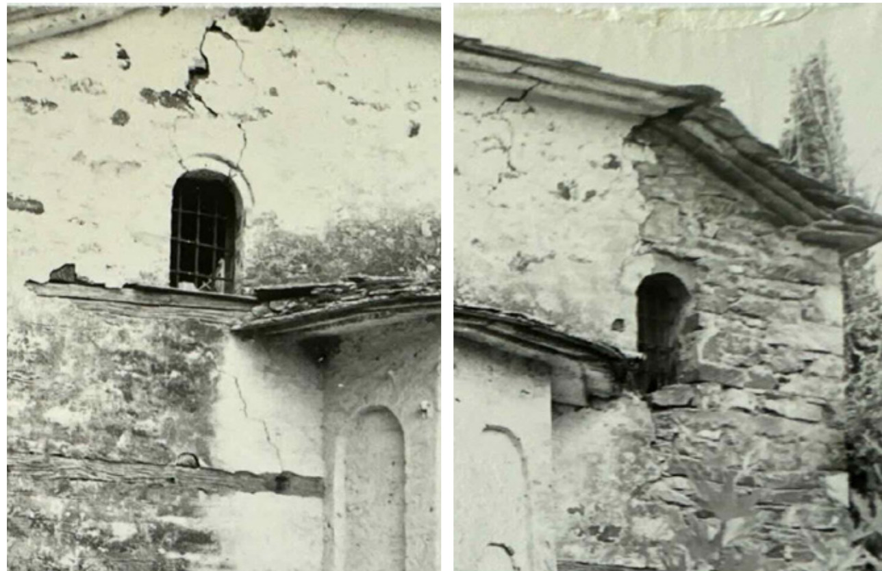
Εικ.190| Φωτογραφία Α όψης όπου φαίνεται πως η ρωγμή στο Π211 υπήρχε ήδη τη δεκαετία του 1970.
