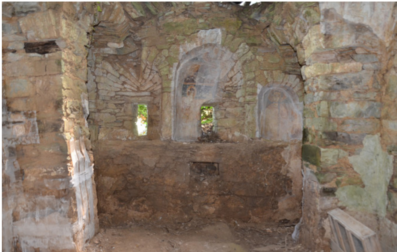
Εικ.270 | Αγ. Νικόλαος, ανατολική όψη, εσωτερικό. Σ. Μαμαλούκος, 06/2019.
