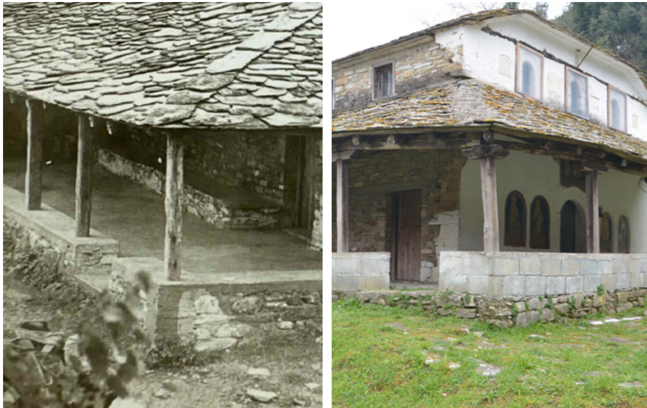
Εικ.159| Η ΒΔ γωνία του περίστωου. Πάνω & Κάτω αριστερά 1973-76, κάτω δεξιά δεξιά 02/2024. Διακρίνεται η διαφορά στο στηθαίο του περίστωου και τα τσιμέντα στη στέγη.
