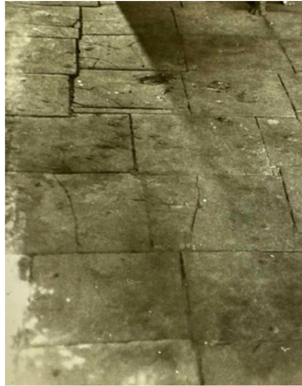
Εικ.208| Το ομφάλιο (πάνω) και η βορειοανατολική γωνία του, από το αρχείο του Μίλτου Πολυβίου. Φαίνεται πως οι πλάκες είχαν σπασίματα από τη δεκαετία του 1970.
