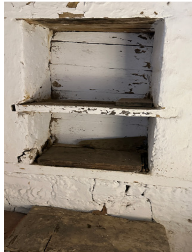
Εικ.185 | Ρωγμές και παθολογία ξύλου ΝΑ γωνία. 02/2024.
