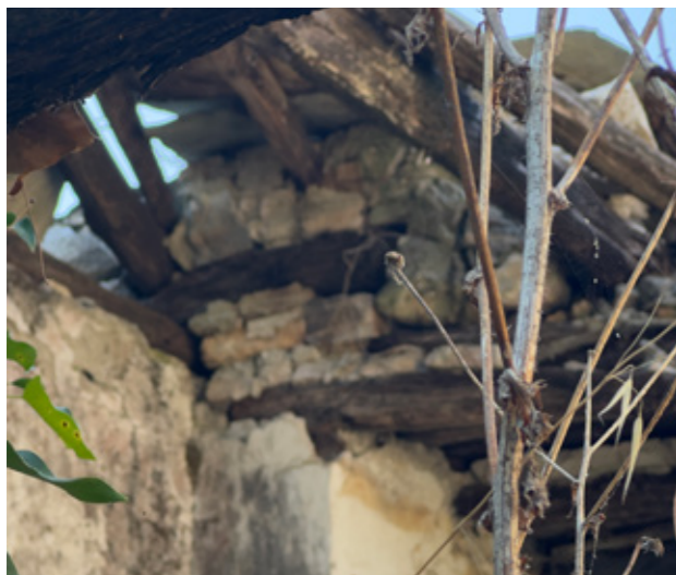
Εικ.251 | Βόρεια πτέρυγα, K110. Κατασκευή στέγης. 08/2023.
