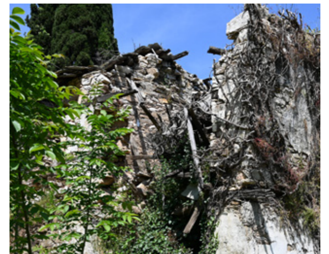
Εικ.246 | Βόρεια πτέρυγα, η τοιχοποιία φτάνει μέχρι την κορυφή της στέγης. 05/2023.
