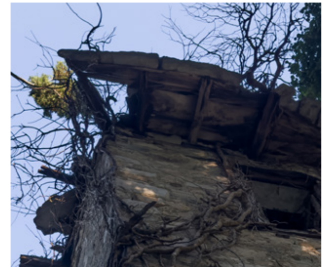
Εικ.245 | Λεπτομέρεια στέγης, ΒΔ γωνία. 08/2023.
