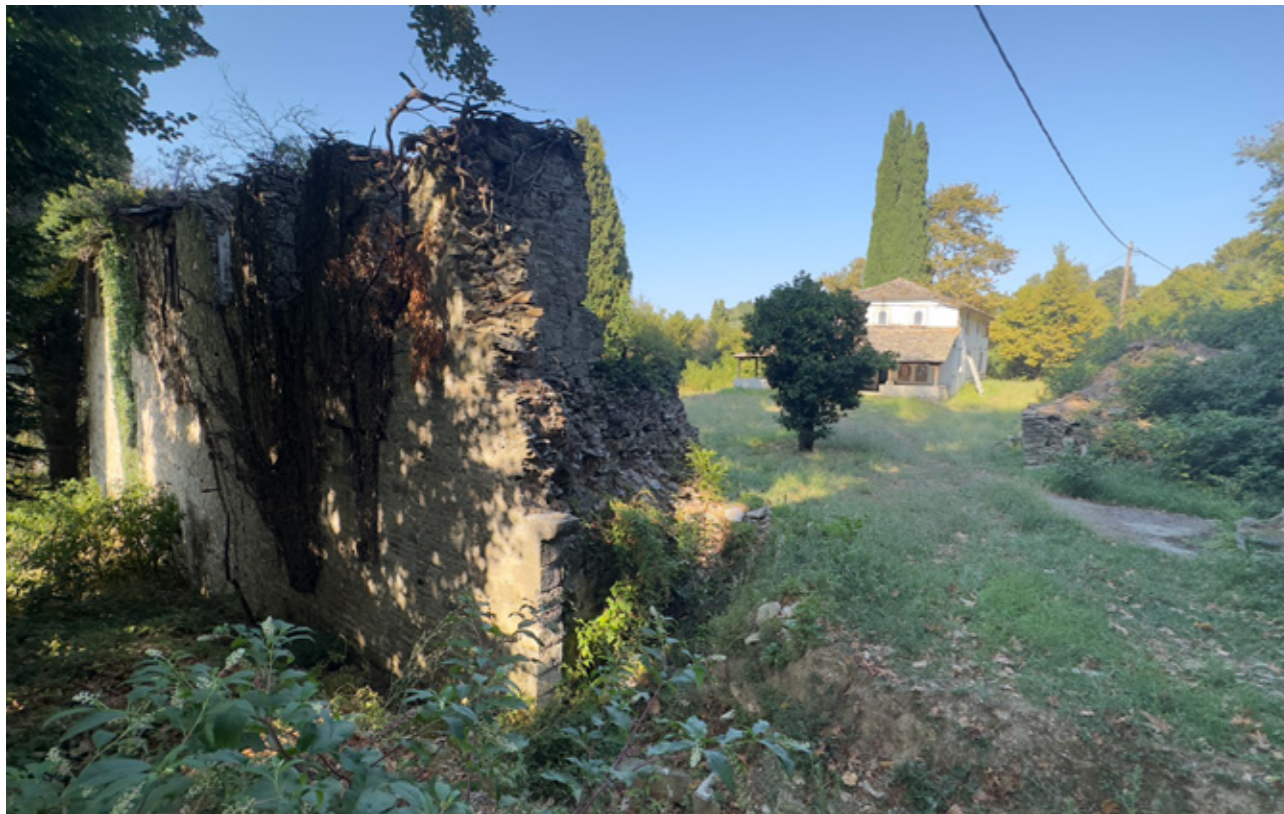
Εικ.236 | Η εξωτερική όψη της δυτικής πτέρυγας, όπου ήταν η είσοδος της μονής. 08/2023.
