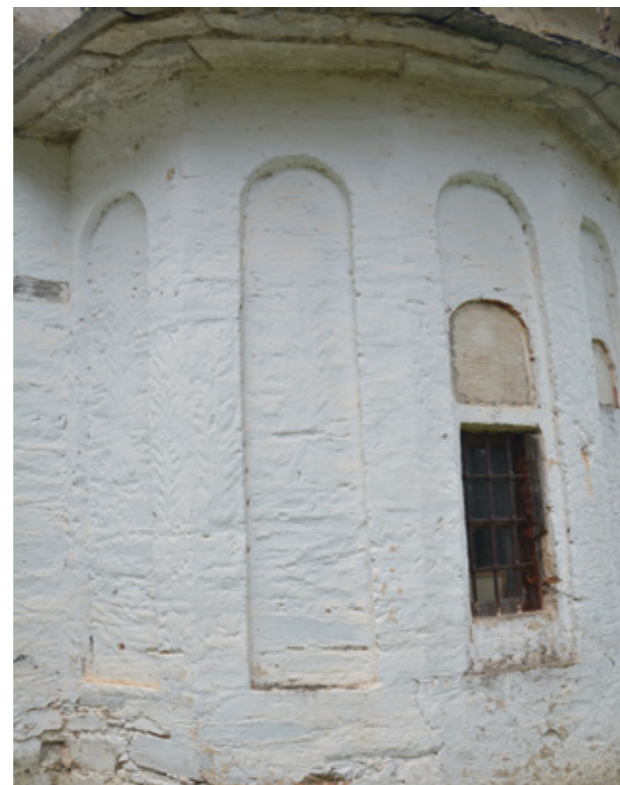
Εικ.196| Πιθανή ρωγμή στην κόγχη του ιερού, κάτω από το γείσο της στέγης του. 08/2023.
