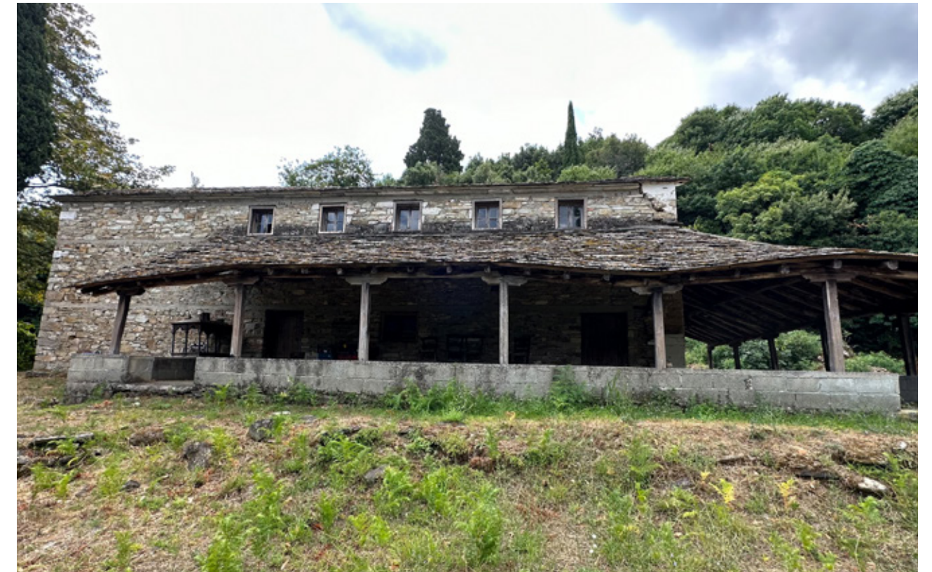
Εικ.87 | Βόρεια όψη. 08/2023.
