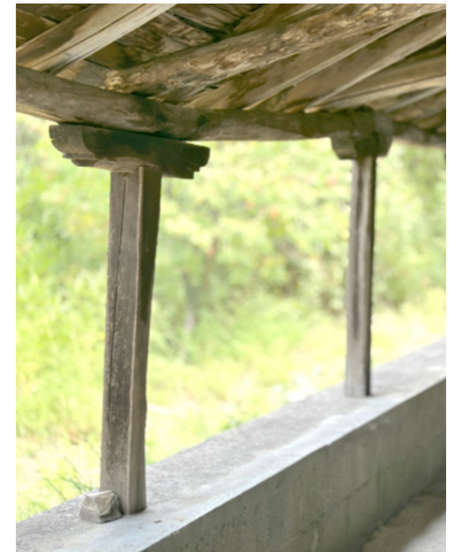
Εικ.157 | Υποστυλώματα περίστωου.
