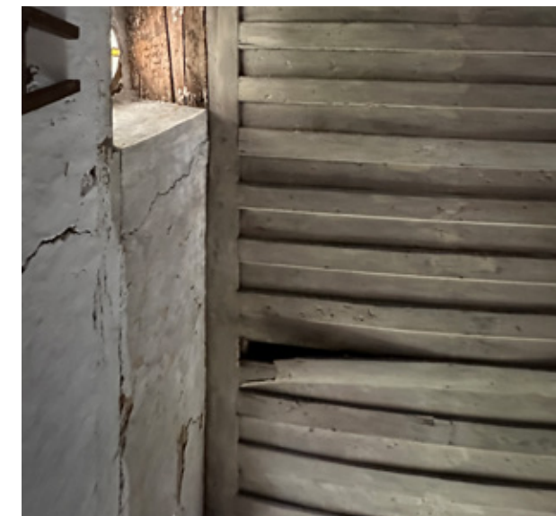
Εικ.213 | Ανατολική όψη, αποκολλημένη σανίδα. 08/2023.
