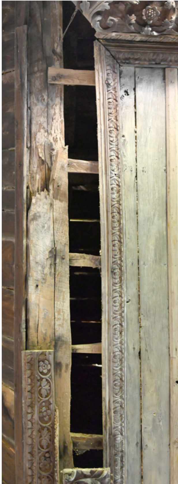
Εικ.144 | Τα πηγάκια στήριξης της οροφής. 02/2024.
