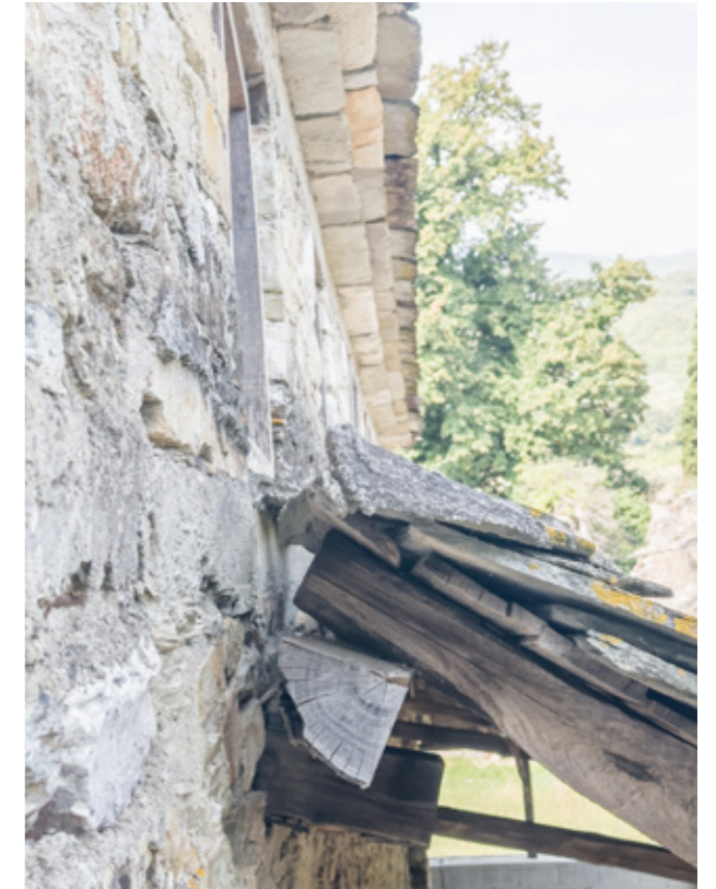
Εικ.158 | Βόρεια όψη: η στήριξη των ξύλων της στέγης του περίστωου.
