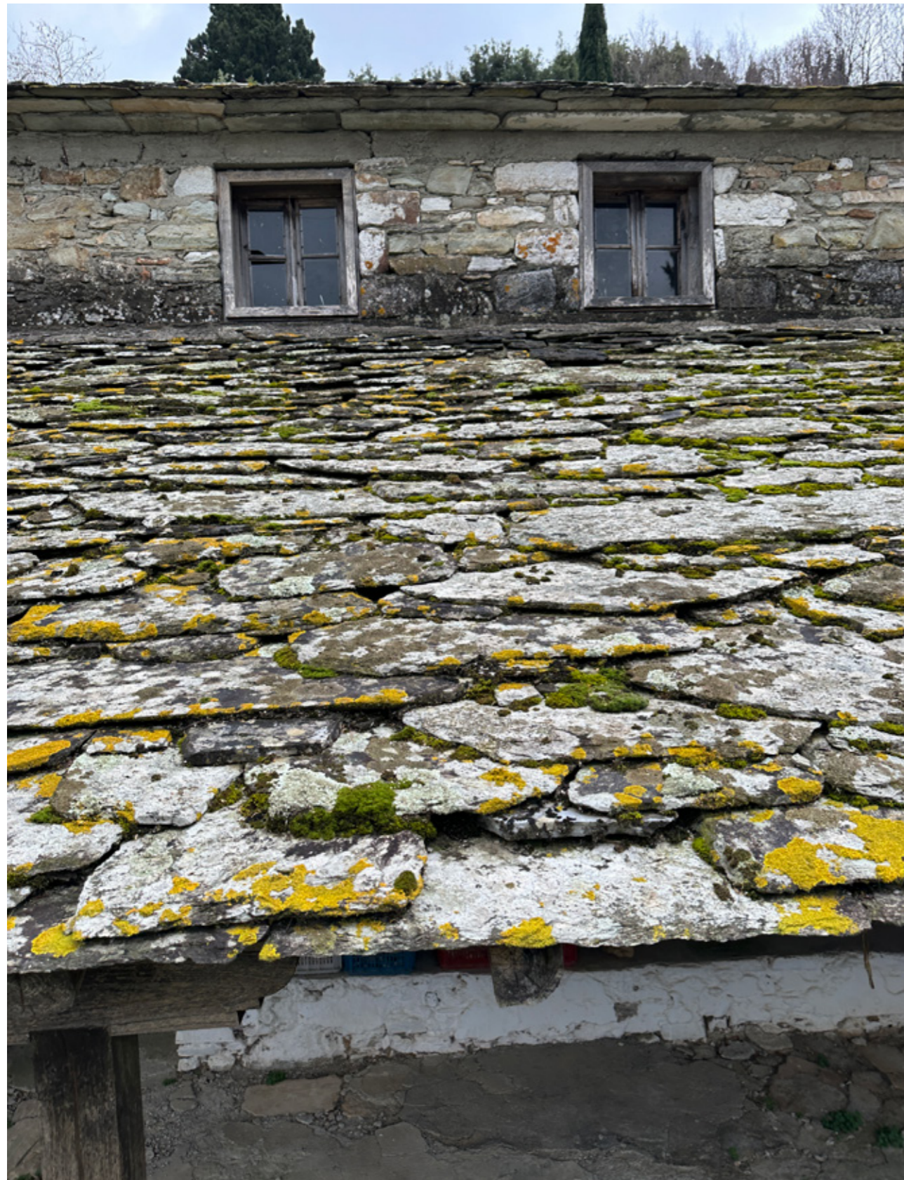
Εικ.205 | Παθολογία στις πλάκες της στέγης της κόγχης του ιερού, και στην όψη. Διαφορετικές μορφές υγρασίας. 02/2024.
