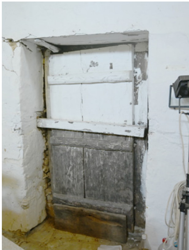
Εικ.126 | Π104 εσωτερική όψη. 08/2023.
