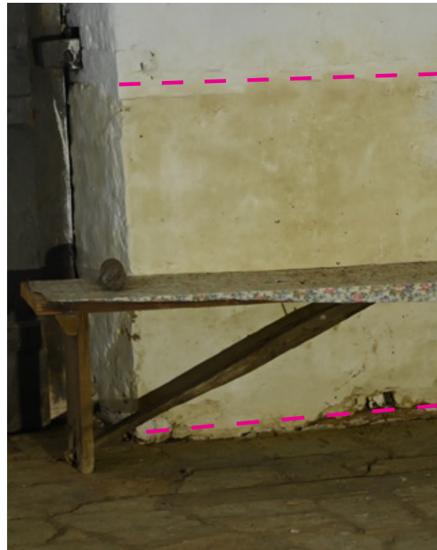
Εικ.116| Ξυλοδεσιά στάθμης 4, 5, Δ όψη. 08/2023.
