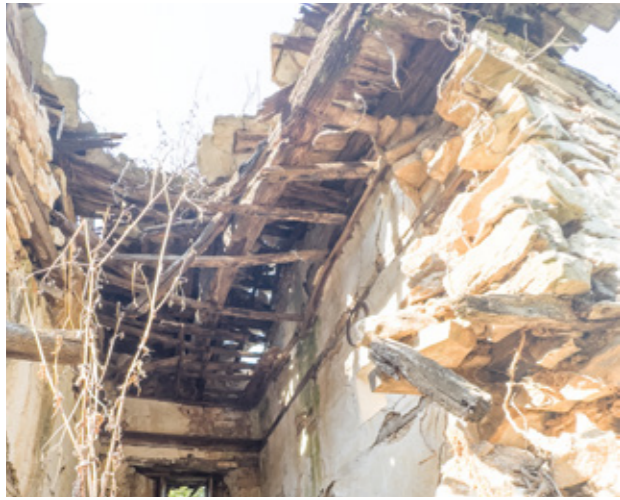
Εικ.249 | Βόρεια πτέρυγα, K111. Ενδείξεις ύπαρξης οροφής. 08/2023.
