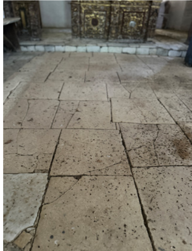
Εικ.209| Αριστερά: λεκέδες από βιολογικούς παρ'αγοντες. Δεξιά: ρωγμές στις πλάκες. 08/2024.
