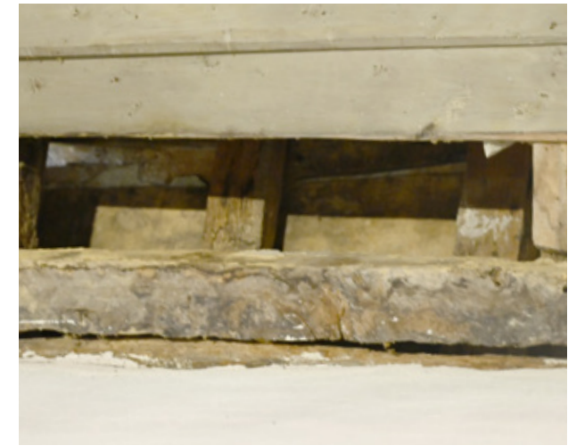
Εικ.214 | Απώλεια σανίδας και παθολογία υλικού λόγω υγρασίας. 08/2023.
