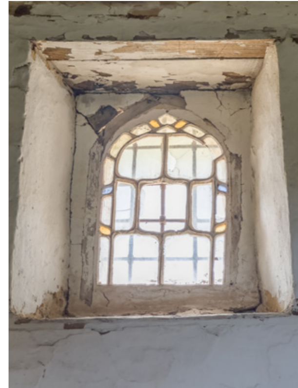
Εικ.130 | Π214, εσωτερική όψη. 02/2024.
