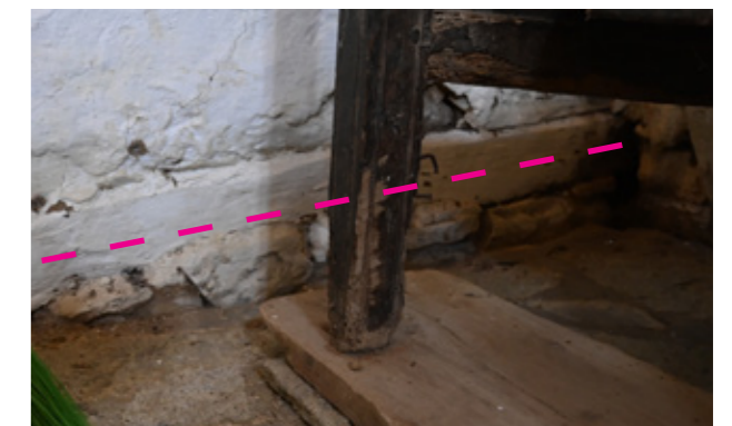
Εικ.113 | Ξυλοδεσιά στάθμης 5, Ν όψη. 08/2023.
