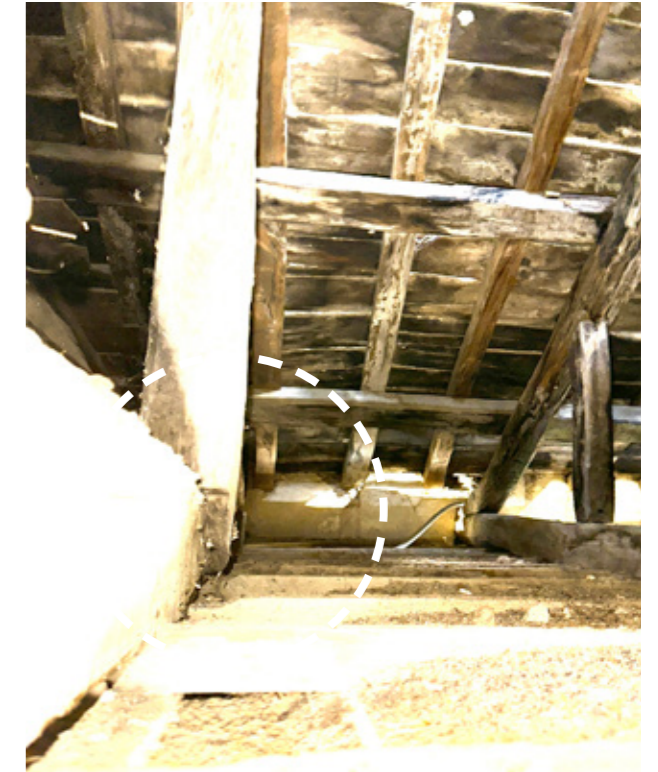
Εικ.149| Φωτογραφία εσωτερικά της στέγης προς Ν.
