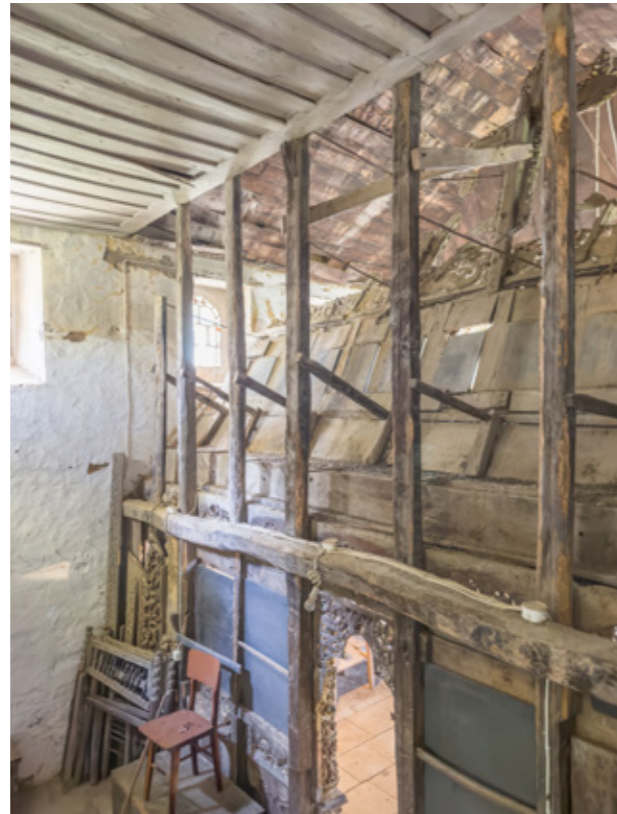
Εικ.101 | Το τέμπλο, πίσω στήριξη. 08/2023.
