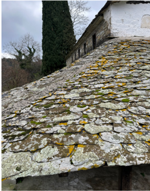
Εικ.168| Βλάστηση στις πλάκες της στέγης, τσιμέντο στις γωνιακές πλάκες και στην κορυφή της στέγης. 02/2024.
