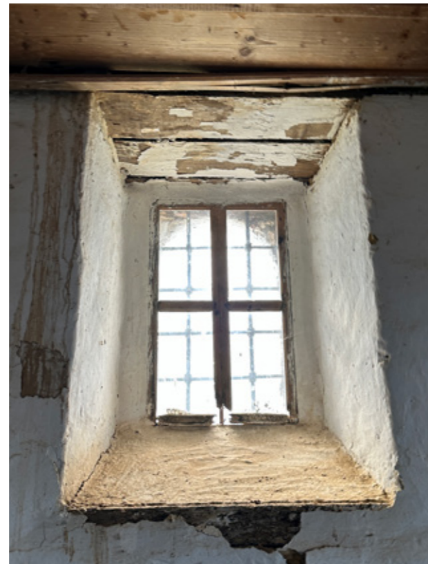
Εικ.140 | Π201, εσωτερική όψη. 08/2023.
