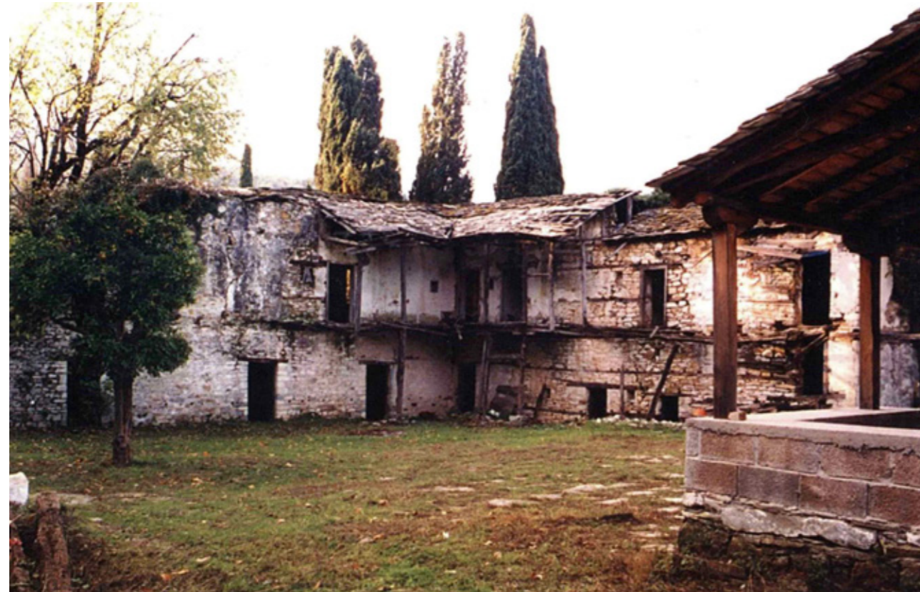
Εικ.225 | Η εσωτερική όψη της βόρειας και της δυτικής πτέρυγας των κελιών. Πάνω: <1967, Κάτω: 2002.
