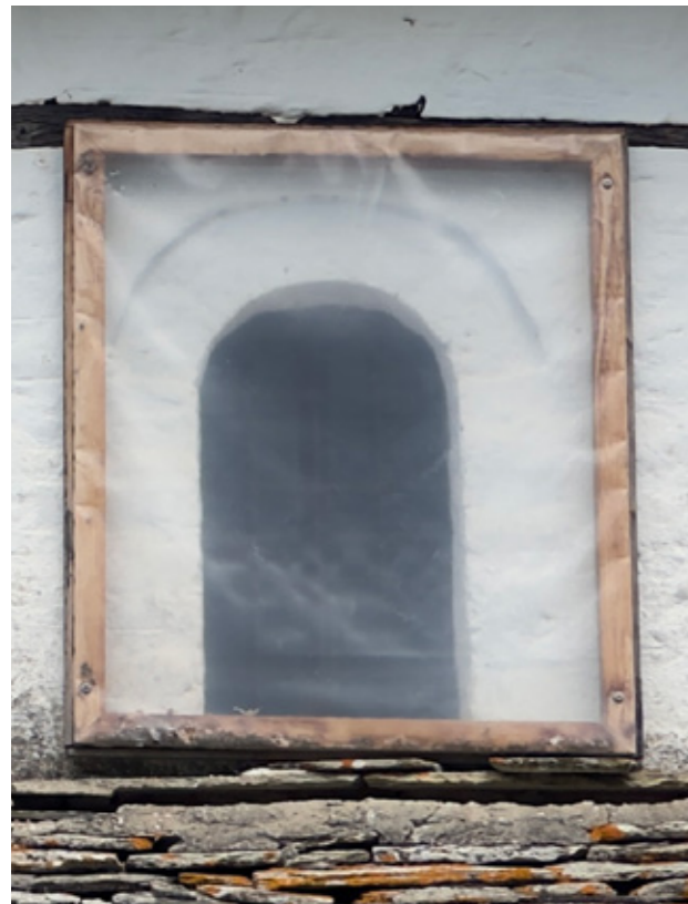
Εικ.139 | Π104, εσωτερική όψη. 08/2023.
