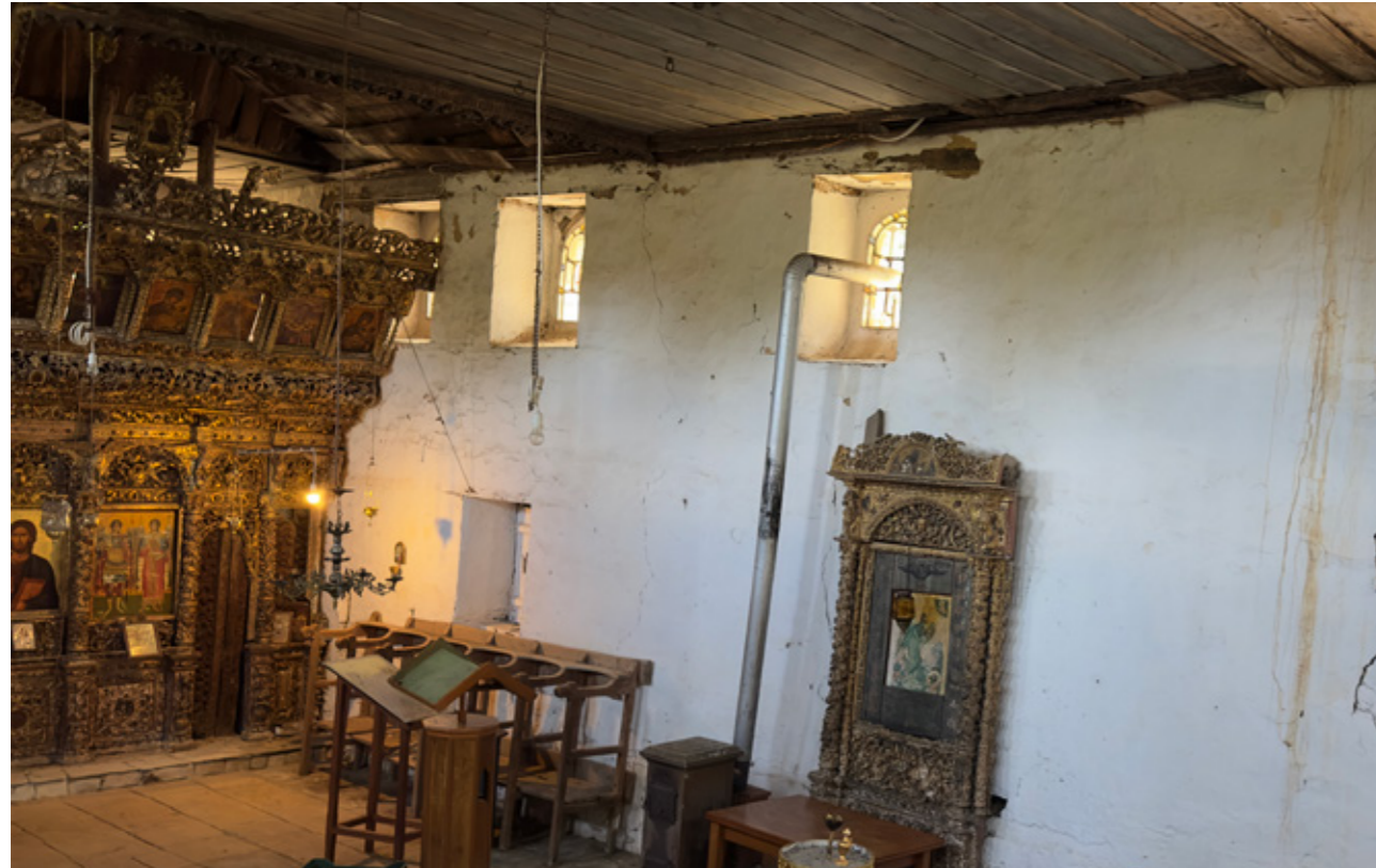
Εικ.65 | Νότια όψη, εσωτερικό. 08/2023.
