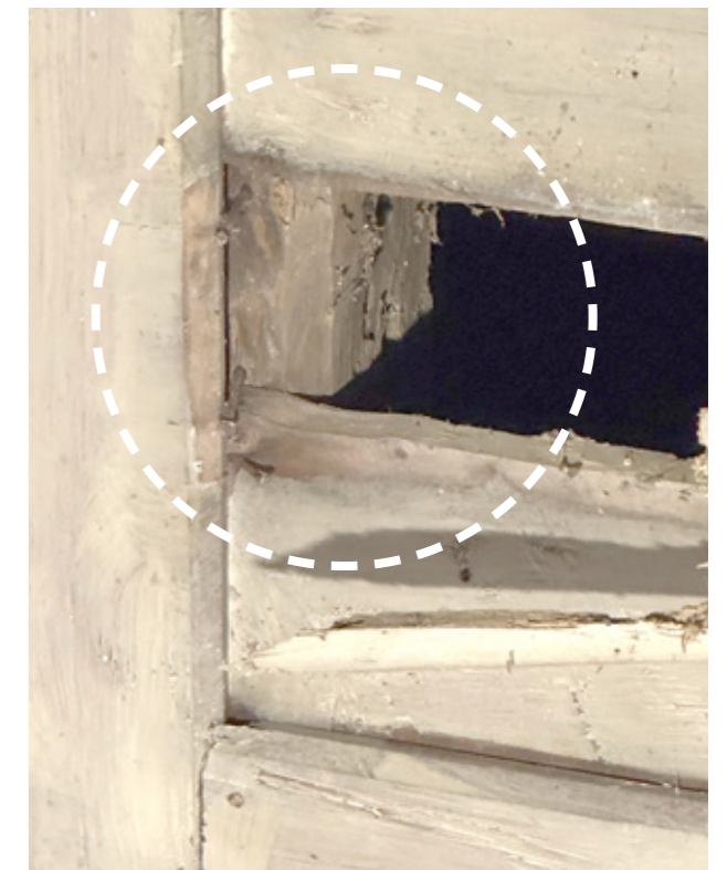
Εικ.147 | Οροφή ιερού, διακρίνεται η σύνδεση των σανίδων. 08/2023.
