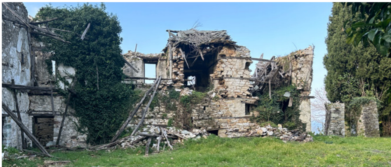
Εικ.228| Πάνω: νότια πτέρυγα, μέση: δυτική πτέρυγα, κάτω: βόρεια πτέρυγα. 08/2023.
