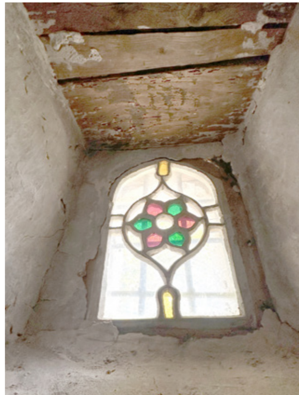
Εικ.134 | Π210, εσωτερική όψη. 08/2023.
