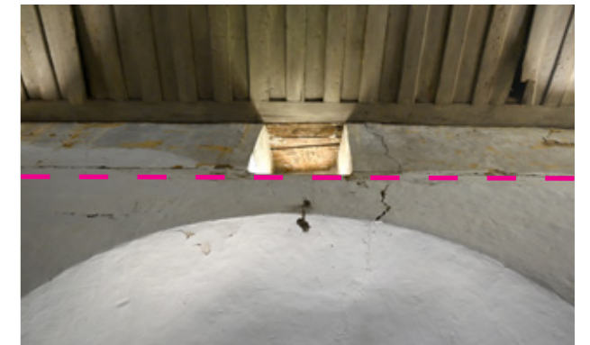
Εικ.117| Ξυλοδεσιά στάθμης 2, Α όψη.
