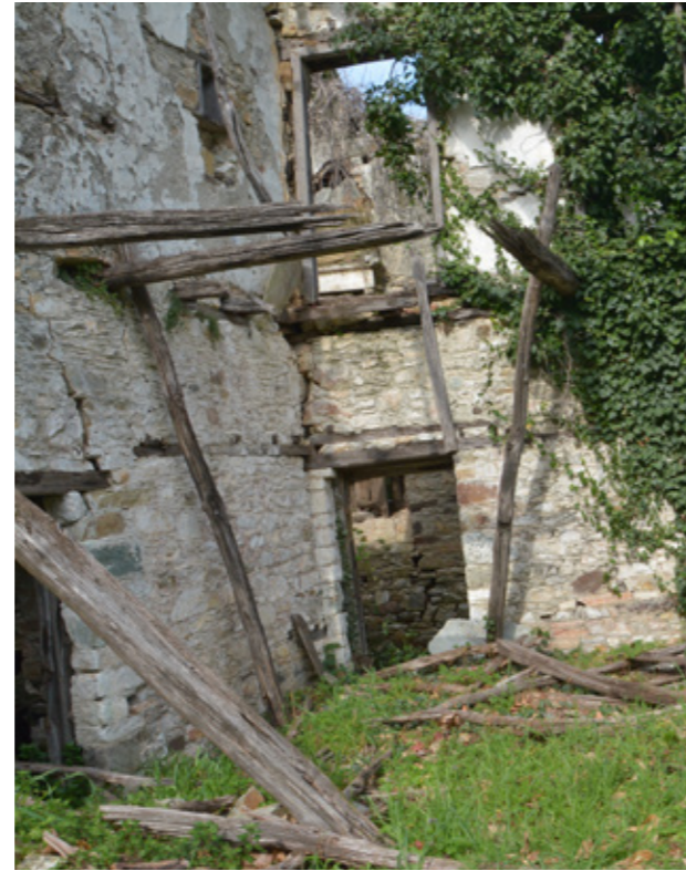
Εικ.261| ΒΔ γωνία, εσωτερική. Καταρρεύσεις δοκαριών χαγιατιού. 08/2023.
