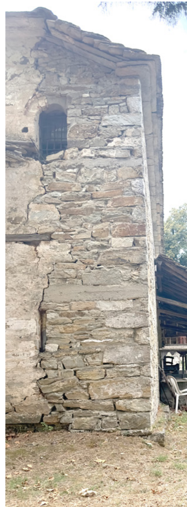
Εικ.161 | Η ένωση του βόρειου τοίχου που ανακατασκευάστηκε τη δεκαετία του 1970 με την ανατολική (αριστερά) και τη δυτική όψη (δεξιά). 08/2023.
