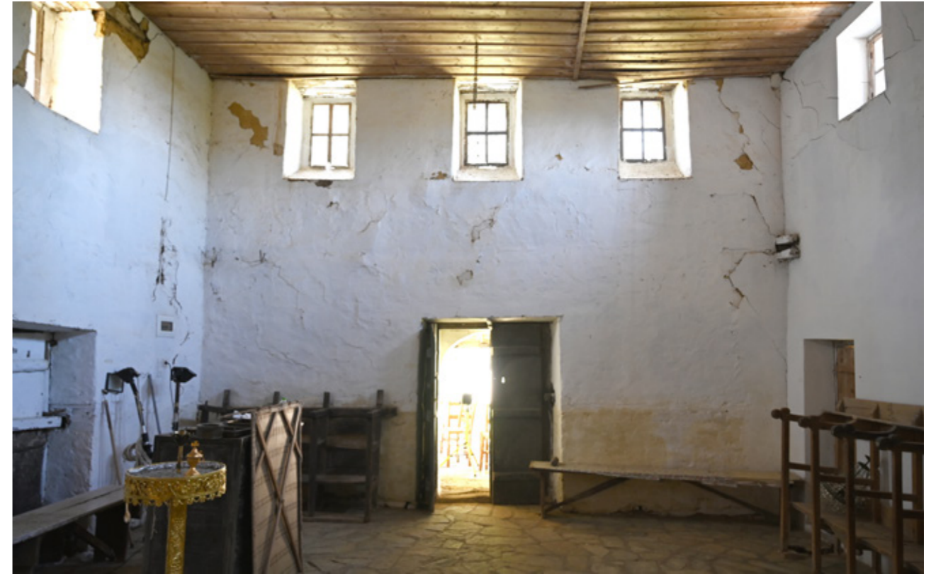
Εικ.67 | Δυτική όψη, εσωτερικό. 08/2023.
