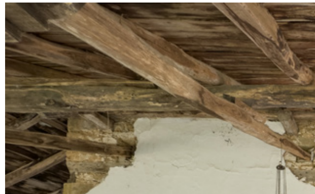
Εικ.115| Ξυλοδεσιά στάθμης 3, Δ όψη. 08/2023.
