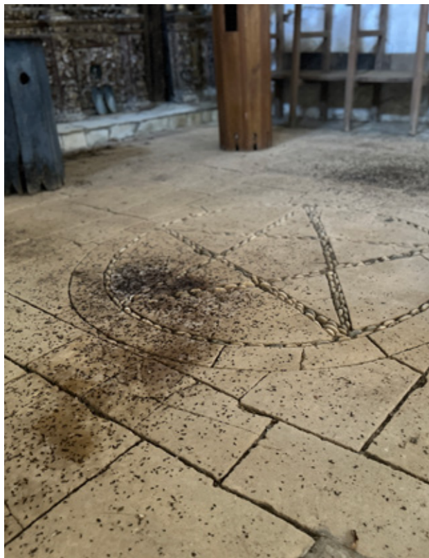
Εικ.209| Αριστερά: λεκέδες από βιολογικούς παρ'αγοντες. Δεξιά: ρωγμές στις πλάκες. 08/2024.
