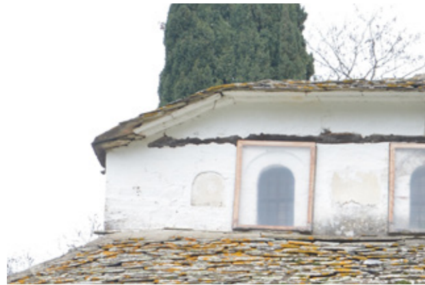
Εικ.114| Ξυλοδεσιά στάθμης 1, Δ όψη. 08/2023.
