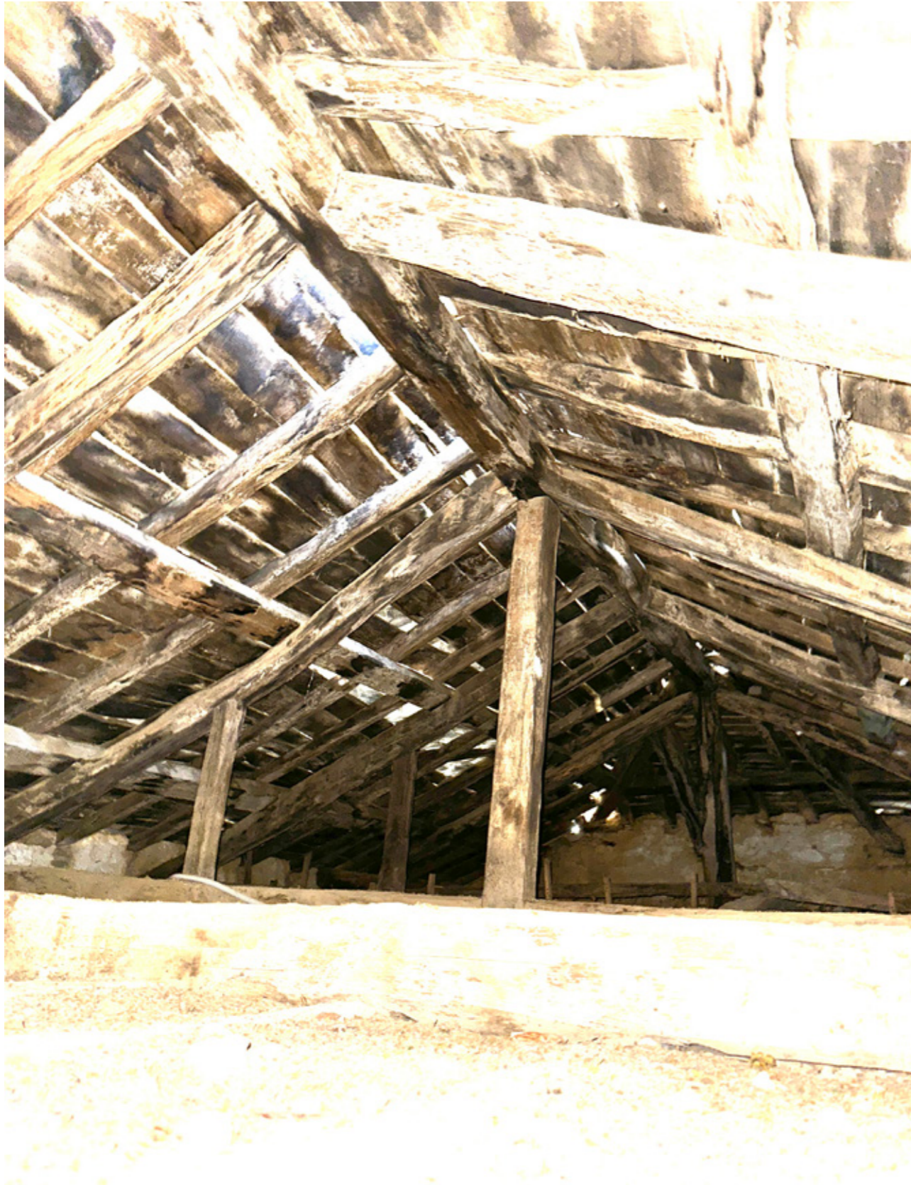
Εικ.148| Φωτογραφία εσωτερικά της στέγης προς Δ. 02/2024.
