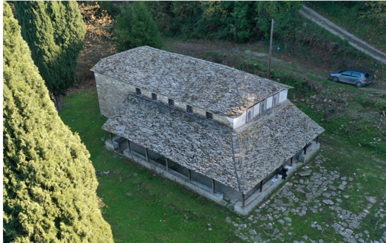
Εικ.93 | Το καθολικό ΒΔ γωνία. Λήψη με drone, Β. Μαμαλούκος, 12/2019.
