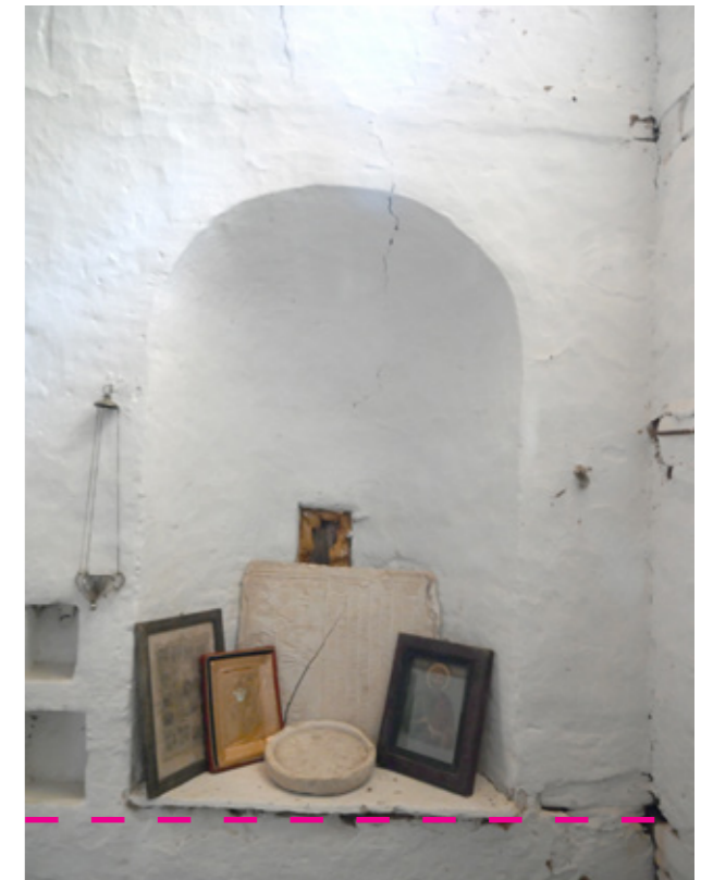
Εικ.118| Ξυλοδεσιά στάθμης 3,4, Α όψη. 05/2023.
