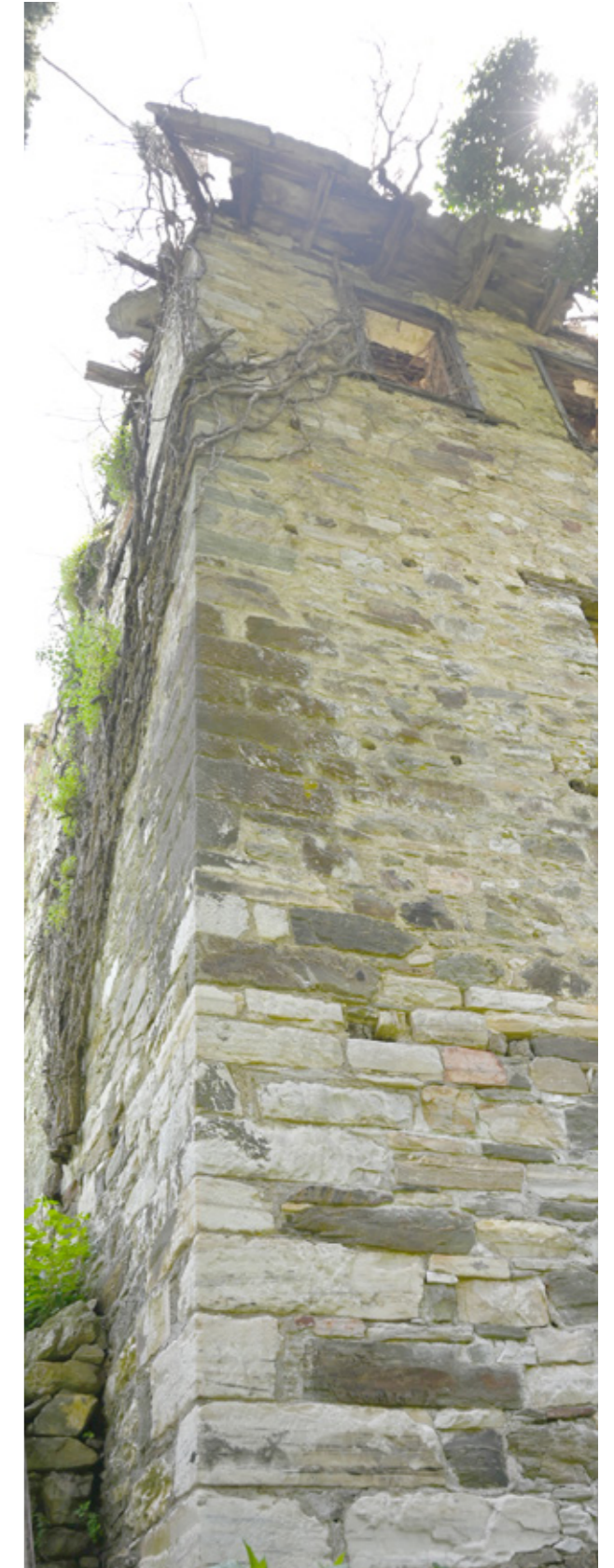
Εικ.237 | Εξωτερική όψη, ΒΔ γωνία. 05/2023.
