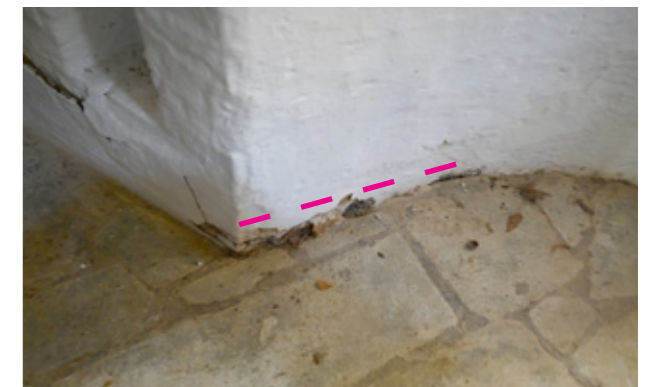
Εικ.119| Ξυλοδεσιά στάθμης 5, Α όψη. 08/2023.
