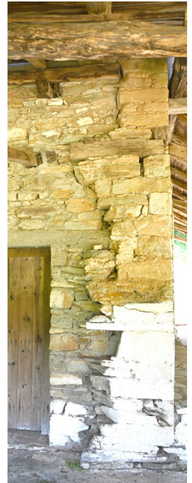
Εικ.161 | Η ένωση του βόρειου τοίχου που ανακατασκευάστηκε τη δεκαετία του 1970 με την ανατολική (αριστερά) και τη δυτική όψη (δεξιά). 08/2023.
