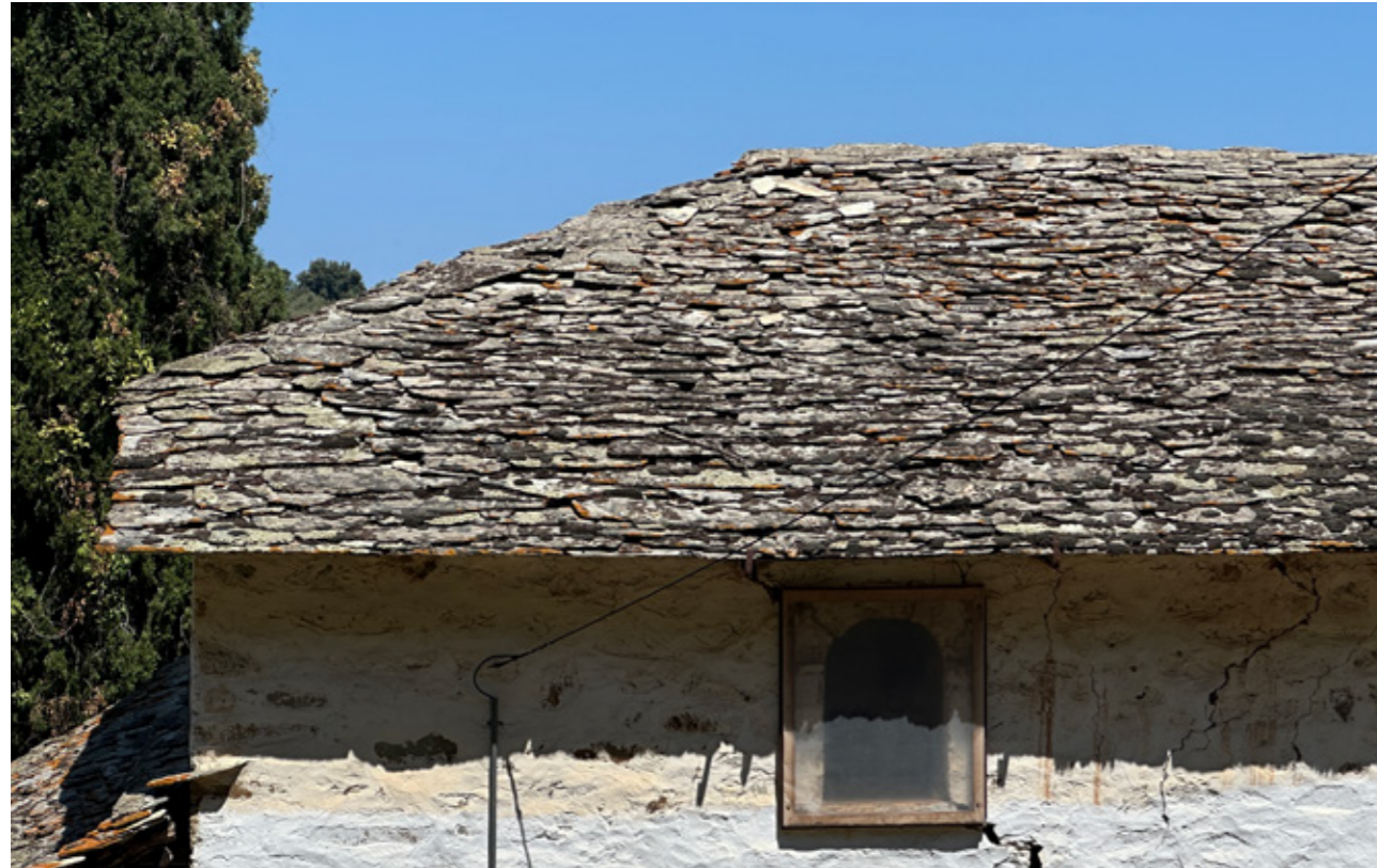
Εικ.217| Η στέγη ΝΔ εξωτερικά. Δεν διακρίνεται κενό ή αποδιοργάνωση στις σχιστόπλακες. 08/2024.
