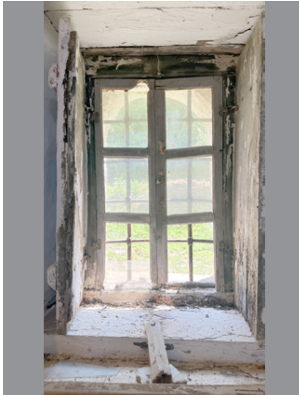
Εικ.129 | Π105, εσωτερική όψη. 08/2023.
