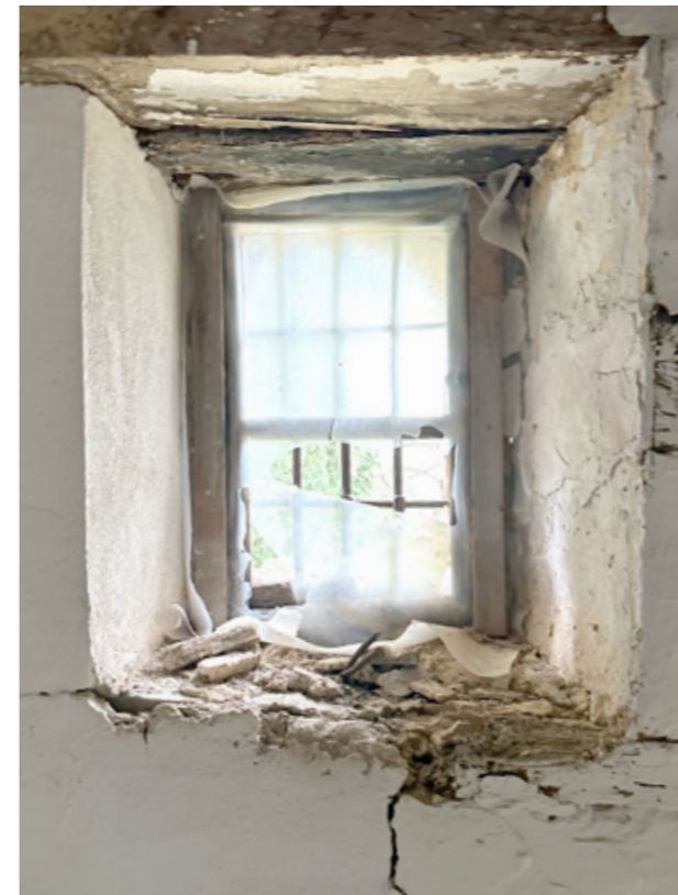
Εικ.137 | Π209, εσωτερική όψη. 08/2023.
