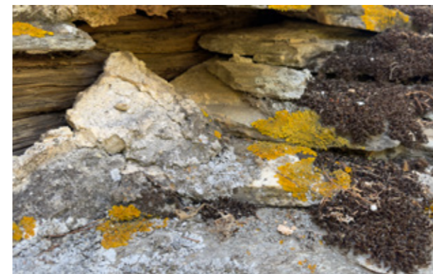
Εικ.120| Ξυλοδεσιά στάθμης 2, Α όψη. 02/2024.
