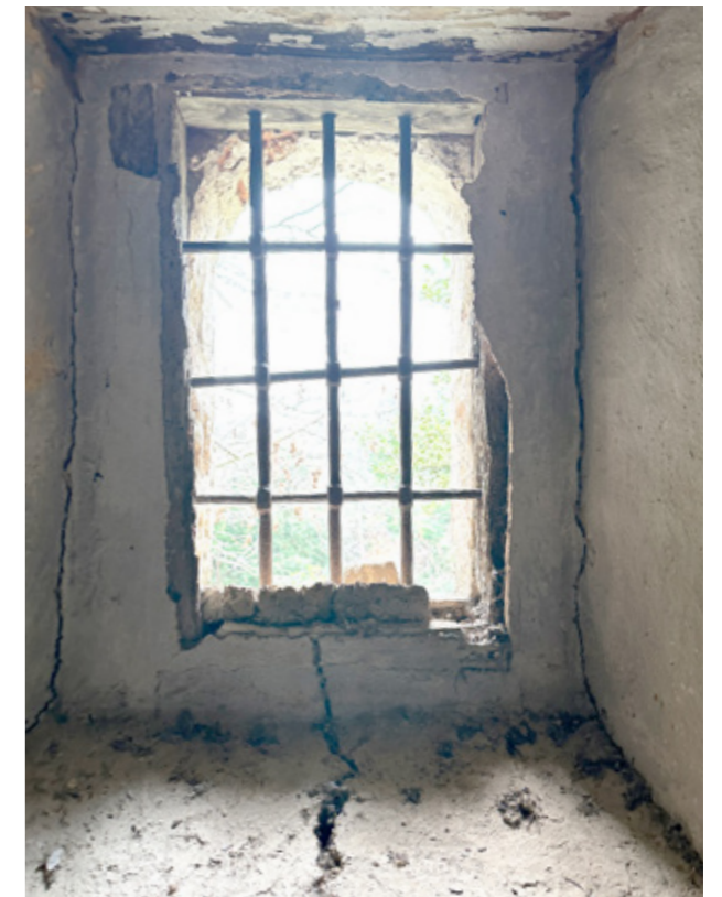
Εικ.138 | Π211, εσωτερική όψη. 08/2023.
