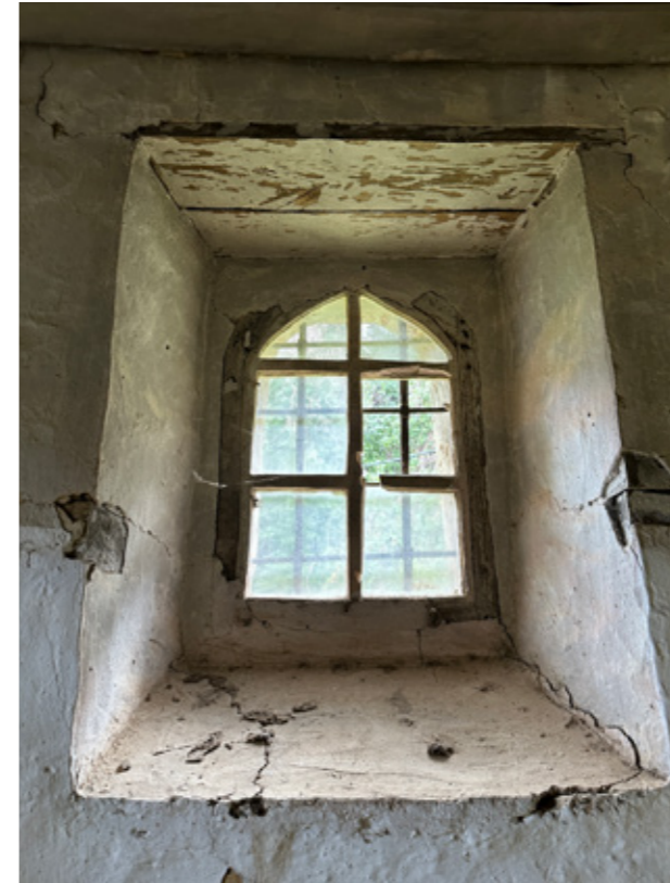
Εικ.135 | Π212, εσωτερική όψη. 08/2023.
