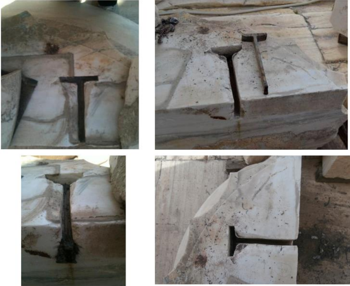
Εικόνα 16 Δείγμα Νο 5. Ήμισυ συνδέσμου «Ταυ» από συμπλήρωμα εχίνου του κιονοκράνου. Αριθμός Αποξήλωσης: 14185
