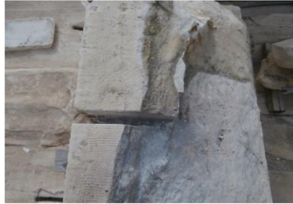
Εικόνα 14 Δείγμα Νο 3. Ήμισυ συνδέσμου «Ταυ» από συμπλήρωμα του άβακα του κιονοκράνου. Αριθμός Αποξήλωσης: 14149.
