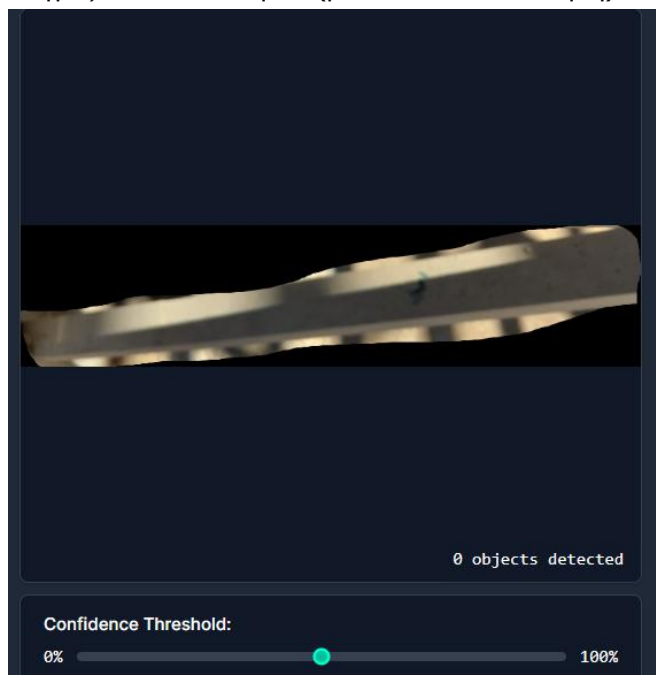
Σχήμα 53 Παράδειγμα εντοπισμού ρωγμών – Μέλος 290 (δεν εντοπίστηκαν)
