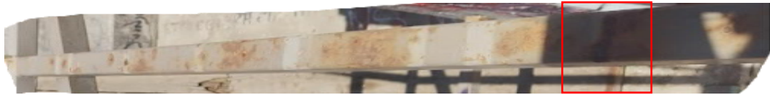
Σχήμα 61 Μέλος 251, που κατηγοριοποιήθηκε ως D (λόγω της διάβρωσης με απώλεια διατομής που υπάρχει στην άκρη)
