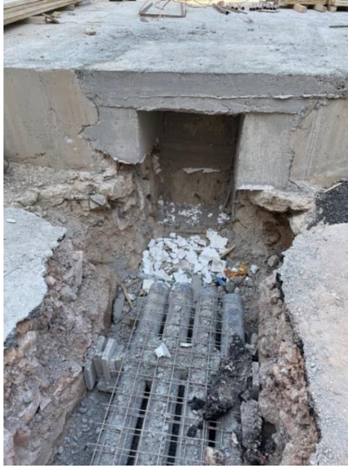
Εικόνα 4.3: Σύνδεση δικτύων ΟΚΩ στις προβλεπόμενες θέσεις των διαφραγματικών τοίχων
