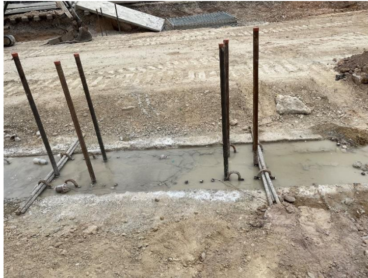
Εικόνα 4.9: Πάνελ διαφράγματος αμέσως μετά την σκυροδέτηση
