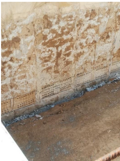
Εικόνα 4.14: Θέσεις couplers στους διαφραγματικούς τοίχους
