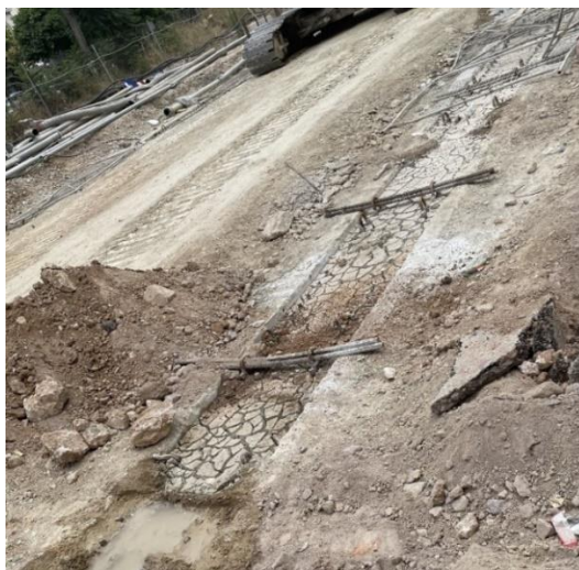
Εικόνα 4.7: Κλωβός σπλισμού μετά την ολοκλήρωση της σκυροδέτησης
