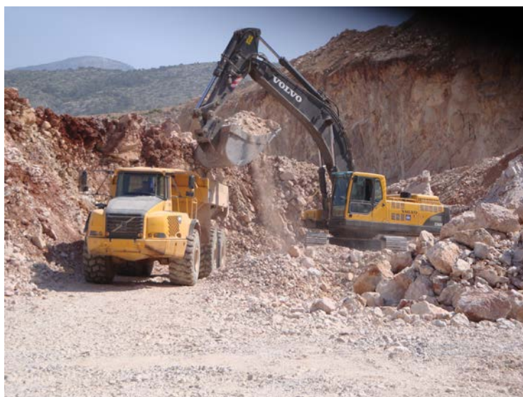
Εικόνα 4-1: Διάταξη φόρτωσης στο εργοτάξιο της μελέτης στα Άνω Λιόσια
