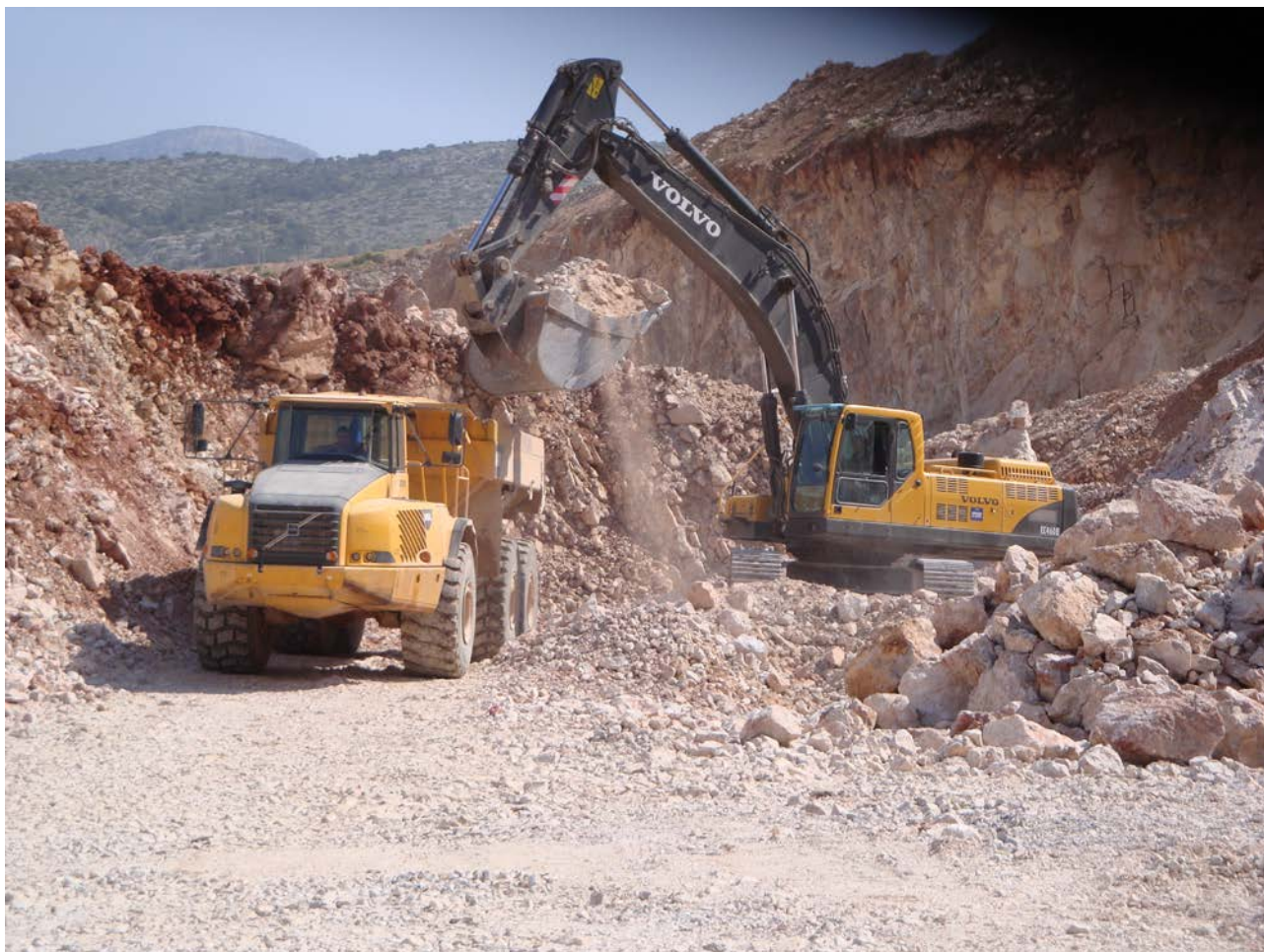
Εικόνα 4-19: Η διάταξη φόρτωσης στο έργο, που μελετήθηκε, της εταιρείας Αίγιστος στα Άνω Λίοσια
