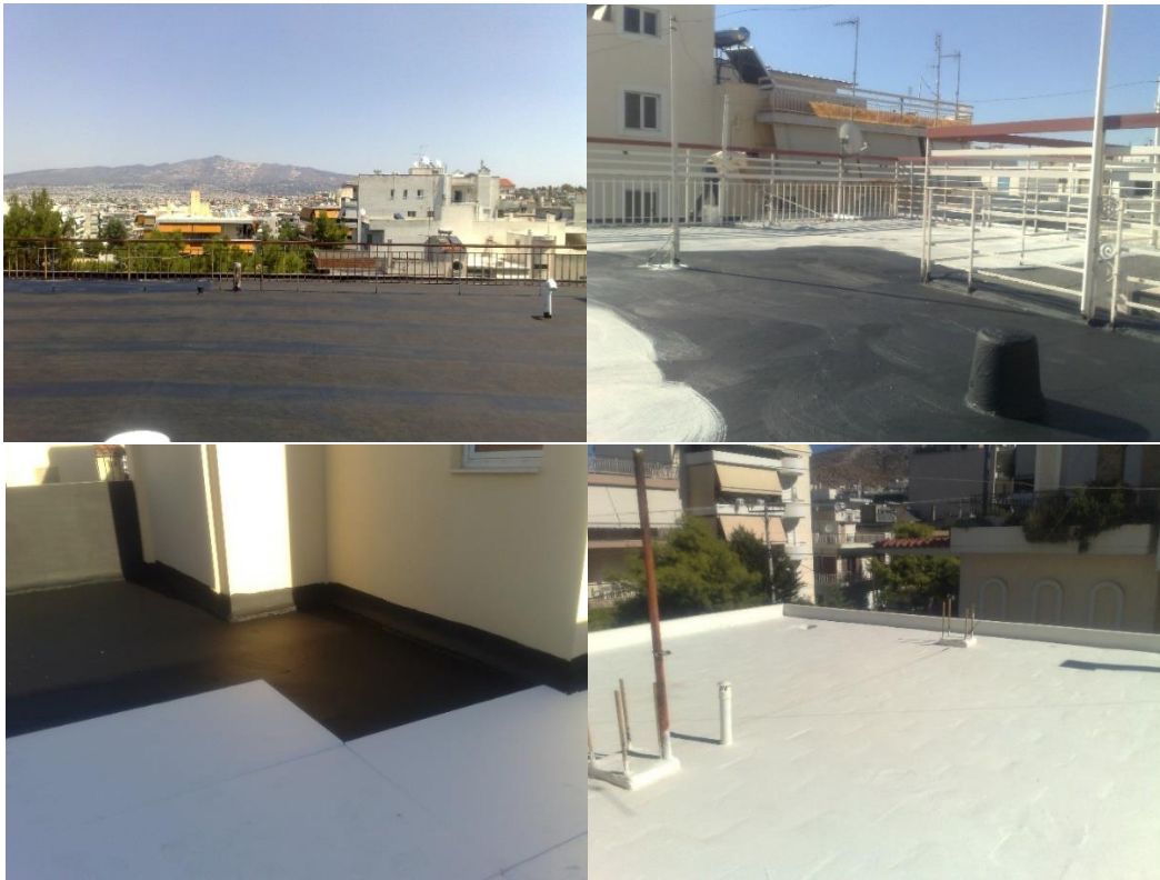
Εικόνα 3.61 : Εξωτερική θερμομόνωση ελαφρού τύπου οροφής
